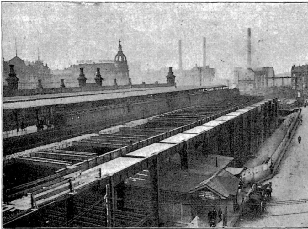
Die Erweiterungsbauten am Bahnhof Friedrichstraße in Berlin. Der auf schweren Eisenträgern ruhende Anbau vor seiner Vollendung.
