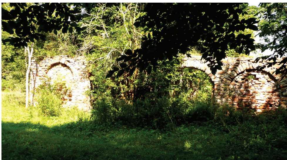
Fot. 7. Zrujnowany, nieogrodzony i zarośnięty dawny magazyn wyrobów gotowych, znajdujący się kilkanaście metrów od zakładu
