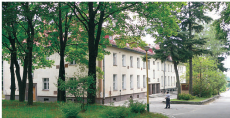
Ryc. 44. Budynek nr 13. Fotografia wykonana w dniu 28.06.2006 roku przed rozpoczęciem przebudowy.
