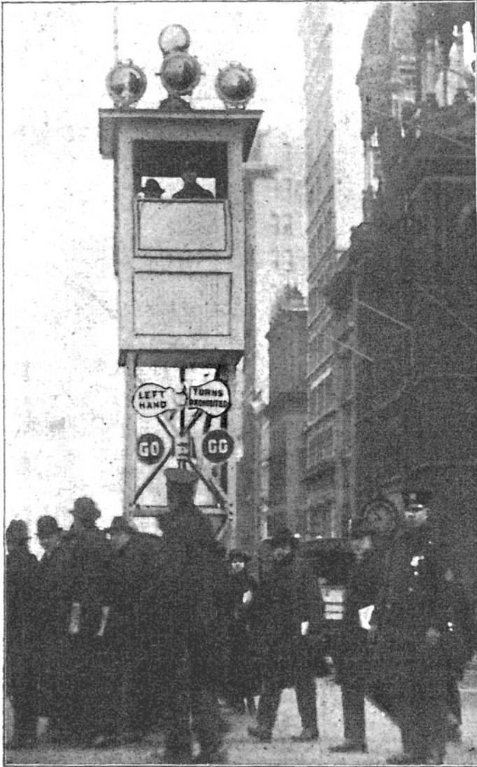
Ein neuartiger Verkehrsregler in Washington. Bei Tage wird der Straßenverkehr durch bewegliche Weisertafeln, bei Nacht durch das verschiedenfarbige Licht der oben befindlichen Scheinwerfer geregelt.
