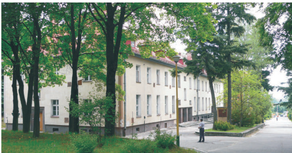
Budynek nr 13. Fotografia wykonana 28.06.2006 roku przed rozpoczęciem przebudowy
