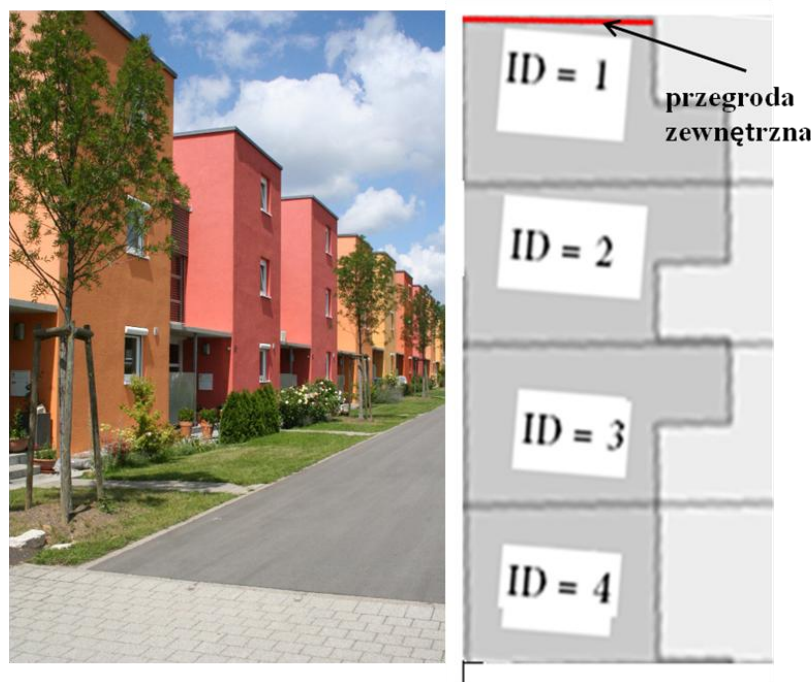
Rys. 5-20: po prawej stronie: odcinek z mapy geoinformacyjnej pokazujący powierzchnie rzutu kilku domków szeregowych, po lewej stronie: zdjęcie tych obiektów.
