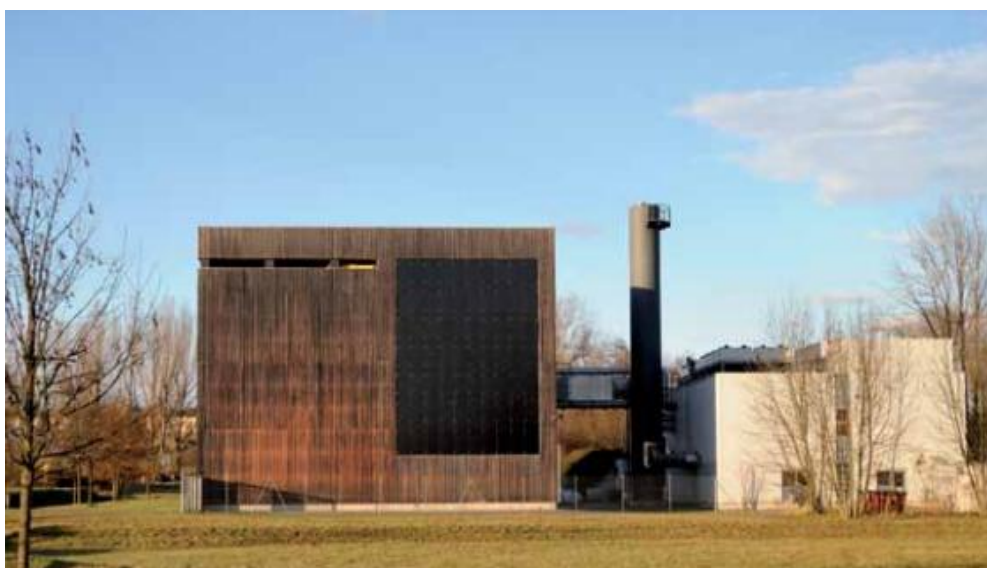
Rys. 4-3: Zdjęcie elektrociepłowni osiedla SHP [22].
