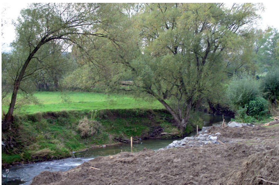
Ryc. 2. Stabilizacja brzegu rzeki Stobnica
