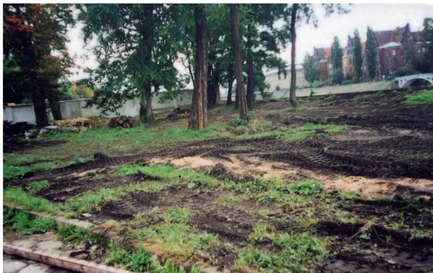
Ryc. 7. Prace przygotowawcze przed rewaloryzacją ogrodu przy ul. Katedralnej 1 (fot. M. Lipska)
