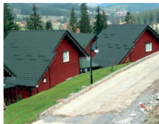
Ryc. 2. Droga zniszczona przez erozję
