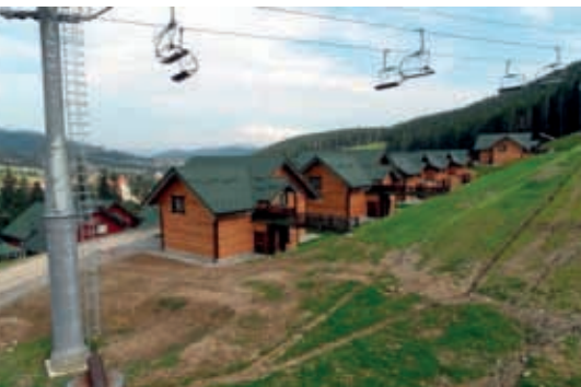
Ryc. 3. Erozja stokowa wzdłuż wyciągu
