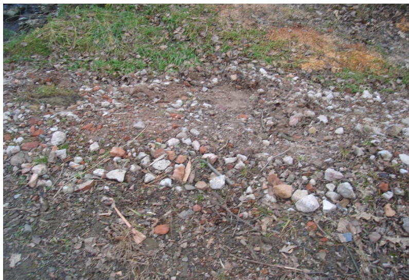
Rys. 5.24. Pozostałość po gruzie budowlanym wykorzystanym do podbudowy betonowej drogi lokalnej. Fot. własna.
