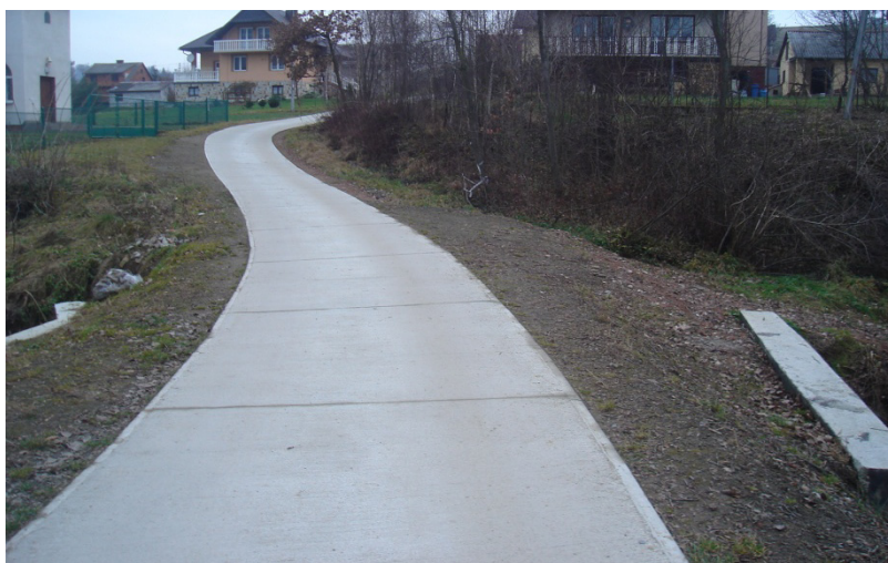
Rys. 5.23. Widok na lokalną drogę betonową z podbudową z gruzu betonowego Fot. własna.
