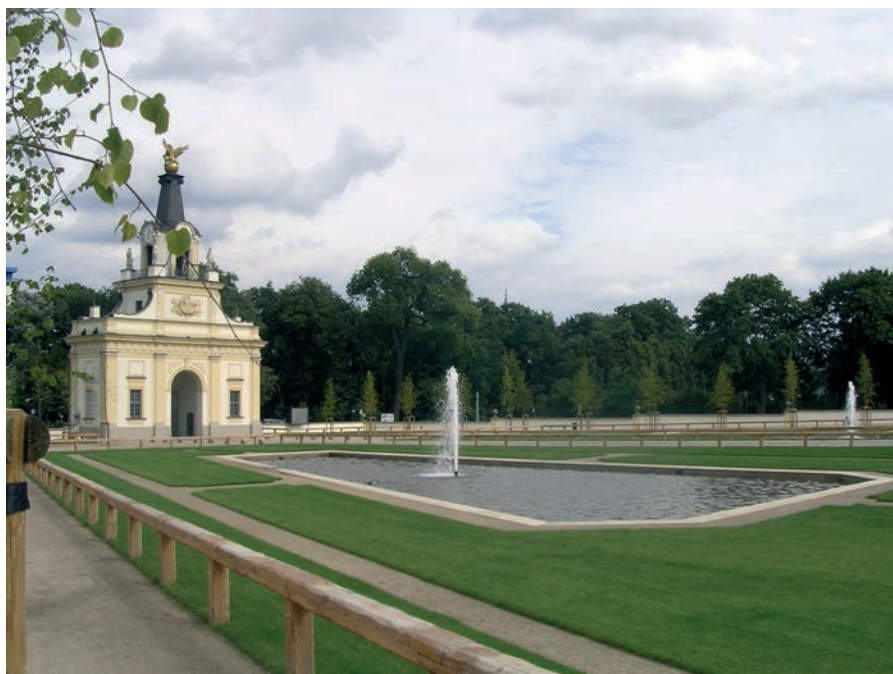
Ryc. 2. Avant court po zakończeniu prac konserwatorskich, 2010 r.
