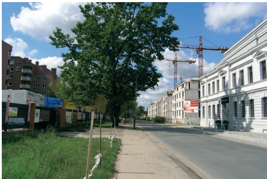
Ryc. 5. Zabudowa mieszkaniowa wypełniająca szczerlnie tereny uwolnione po przemyśle w dolinie Jasienia
