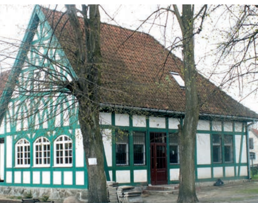
Ryc. 6. Kadyny. Dawna gospoda wzniesiona w konstrukcji ryglowej
