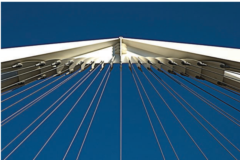
Kładka dla pieszych na autostradzie A13 koło Bolonii – węzeł podwieszenia cięgien (fot. M. Majowiecki)
