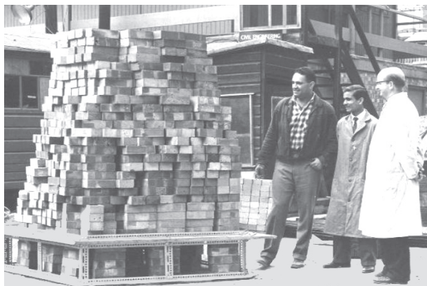
Il. 5. Studenci DIC H. Nooshin i D. Sarna razem z Z.S. Makowskim testują jedną z jednostek konstrukcji skorupowej pod obciążeniem grawitacyjnym w Imperial College, 1962 r. (źródło: Space Structures Research Centre Archives, University of Surrey)
