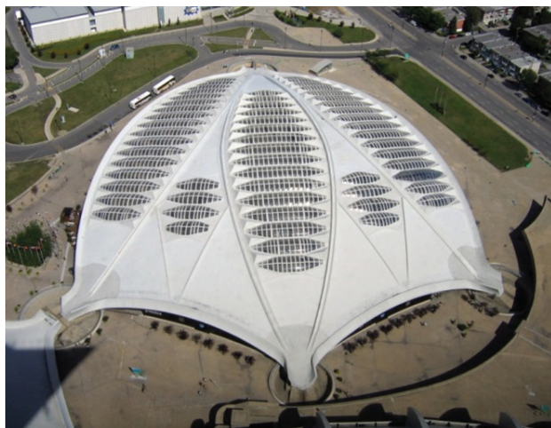
Il. 3. Widok welodromu z lotu ptaka: żebra są widoczne zarówno z wewnątrz, jak i na zewnątrz, podkreślając kształt „liścia klonu” (fot. PtitLutin; http://upload.wikimedia.org/wikipedia/commons/a/a7/Biodome_Montreal.jpg , CC BY SA 2.5)
