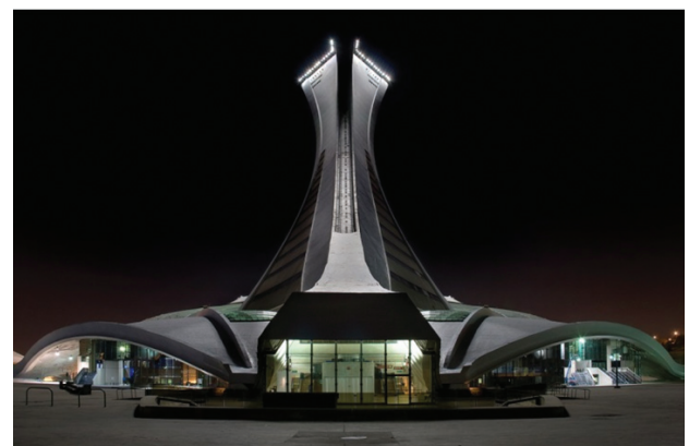
Il. 2. Dynamika wizualna kształtu Wieży Olimpijskiej wraz z przyległymi powłokami żebrowymi, kryjącymi we wnętrzu pływalnię olimpijską (fot. Acarpentier; http://upload.wikimedia.org/wikipedia/commons/6/64/Le_Stade_Olympique_de_Montr%C3%A9al_Nuit_Arriere_Edit_1.jpg , CC BY 3.0)
