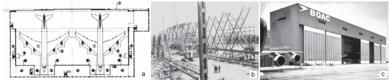
Il. 8. Hangar 01 do konserwacji samolotów Boeing 747 na lotnisku Heathrow w Londynie: a) schematyczny widok hangaru z góry, b) dźwigar grzbietowy i fryzowy w trakcie konstrukcji, c) wejście do hangaru (źródło: Space Structures Research Centre Archives, University of Surrey)
