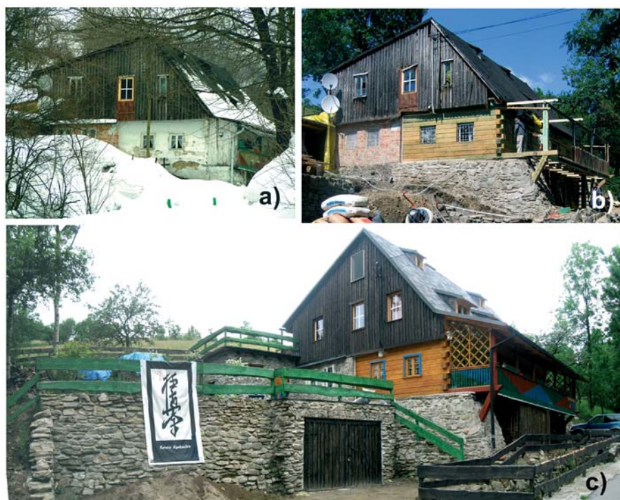
Ryc. 4. Rekonstrukcja obiektu drewnianego, stan: a) przed remontem; b) w trakcie remontu; c) aktualny, po remoncie
