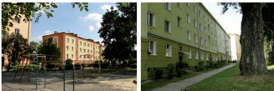
Ryc. 2. Zabudowa osiedla RDM i plac zabaw na wewnętrznym dziedzińcu (fot. M. Sosnowska, 2010 r.)
