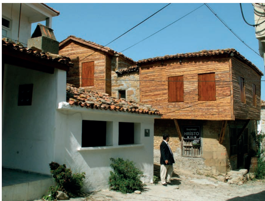
Ryc. 5. Charakterystyczna zabudowa tureckich wysp: kamienny parter i drewniane piętro (fot. A. Podolska)
