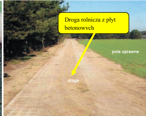
Rys. 5. Droga rolnicza z ażurowych płyt betonowych Fig. 5. An agricultural road made of open-work concrete plates
