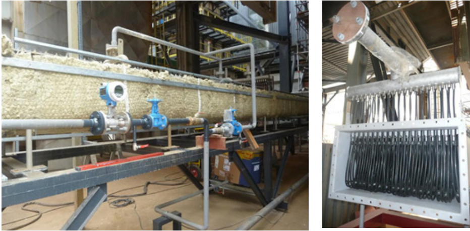
Rys. 4. Widok wymiennika ciepła w trakcie montażu na stanowisku pilotowym
