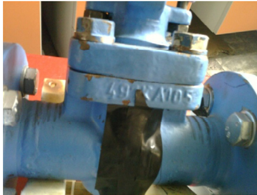
Rys. 4. Badany zawór DN 50 z nalejoną czarną taśmą przykręcony do rurociągu
