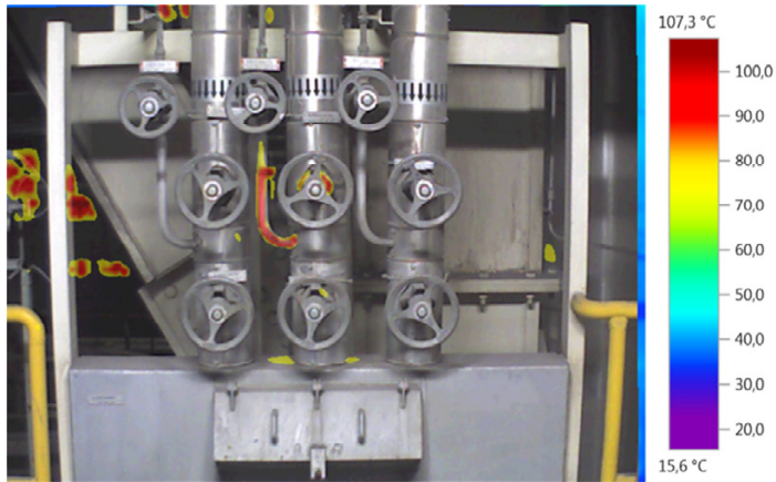
Rys. 5. Zawory zamykające odpowietrzenia za przegrzewaczami pierwotnymi pary
