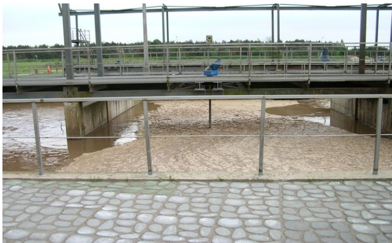
Rys. 5. Komora denitryfikacji z mieszadłem wolnoobrotowym
