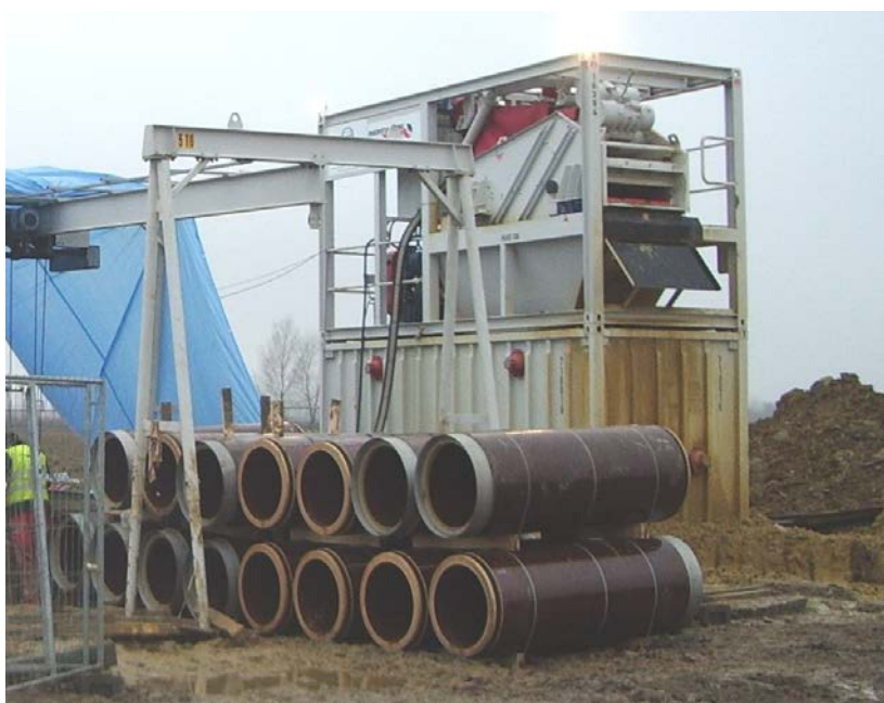
Rys. 3. Rury kamionkowe stosowane w mikrotunelowaniu przy budowie kanalizacji w okolicach lotniska we Wrocławiu (zdjęcie własne)
