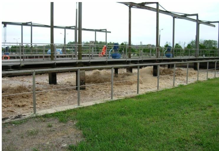
Rys. 6. Komora nityfikacji z aeratorem powierzchniowym
