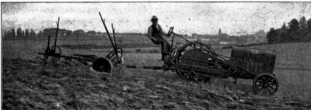
Abb. 4. — Deutscher Trekker mit einem Treibrad (Seitenansicht).
