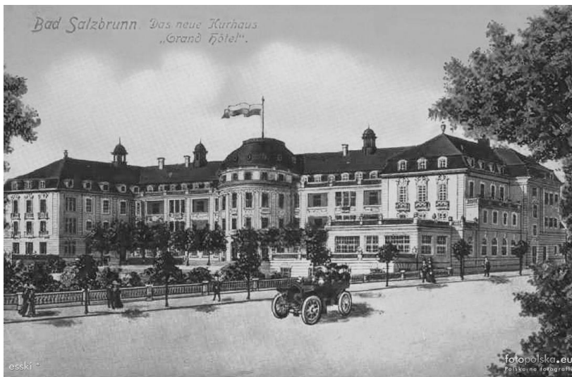
Fot. 4. 1912, Dom Zdrojowy – dawniej Grand Hotel
