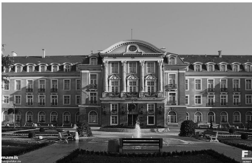
Fot. 9. 2010, Fasada frontowa i główne wejście do Domu Zdrojowego Źródło: http://www.fotopolska.eu/147201,foto.html [dostęp: 05.04.2014 r]
