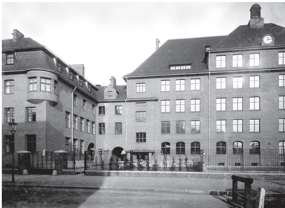
Il. 5. Wrocław, szkoła ludowa przy ul. Kamiennej (Steinstraße 84–86), fragment fasady około 1912 (fot. E. v. Delden, H. Götz [BUWr OZG, inw. fot. 1175])
