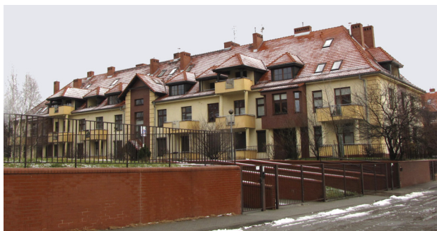
Il. 4. Adaptacja budynków koszarowych na cele mieszkaniowe; Wrocław ul. Zwycięska (fot. M. Rudnicka-Bogusz)
