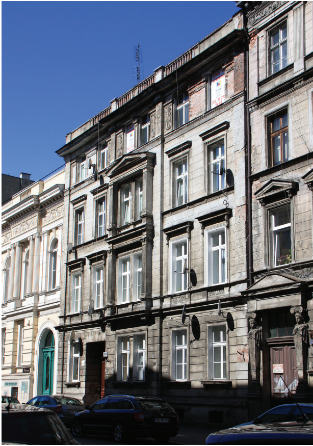
Il. 3. Wrocław, kamienica przy ul. Lelewela 13, elewacja frontowa (fot. A. Tomaszewicz, 2014)
