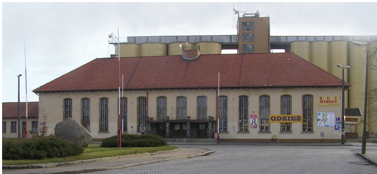
Il. 4. Dworzec kolejowy w Olsztynku. Stan współczesny (proj. H. Conradi z zespołem, fot. J. Salm)
