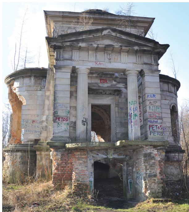
Il. 4. Grobowiec rodziny Samsona Wollera w Leśnej – elewacja frontowa, stan obecny (fot. E. Grochowska)
