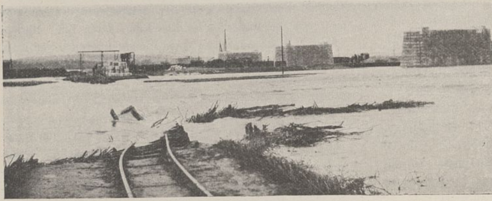
Abb. 9. Hochwasser auf der Baustelle im April 1907.
