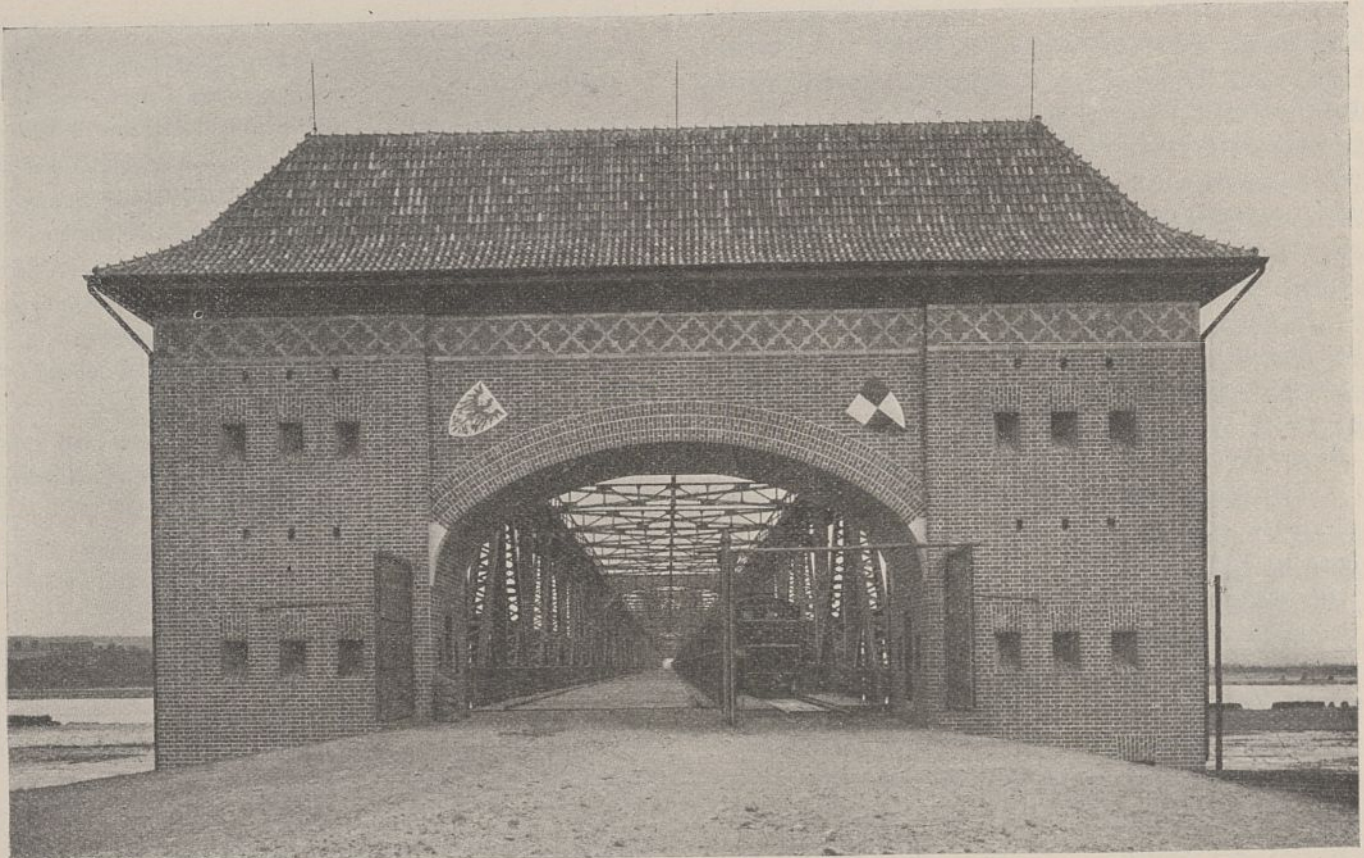
Abb. 2. Die Weichselbrücke bei Marienwerder. Turmaufbau.
