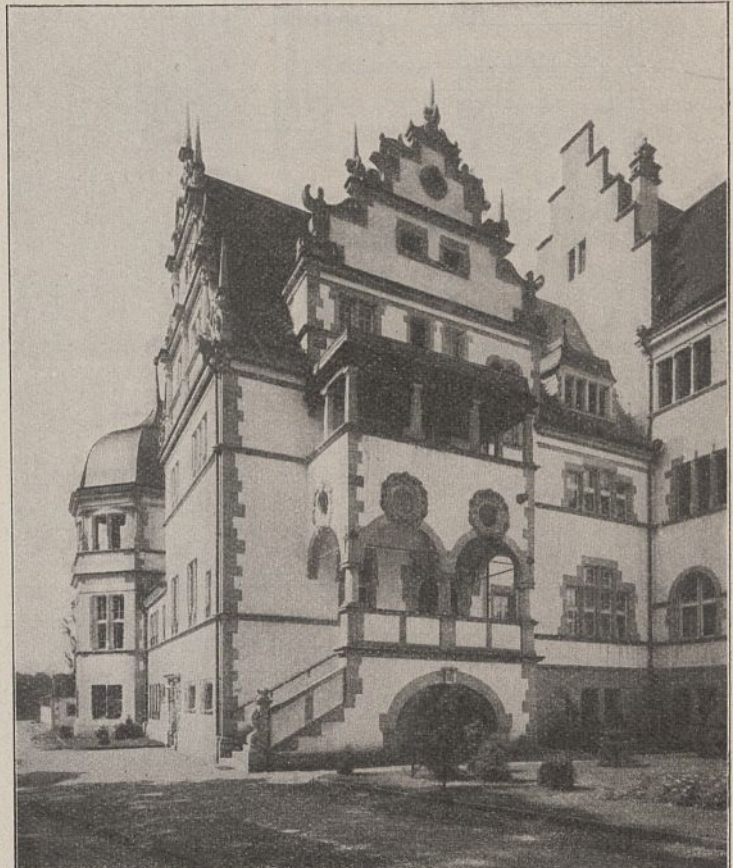
Abb. 7. Treppenaufgang zum Dienstwohnhaus.
