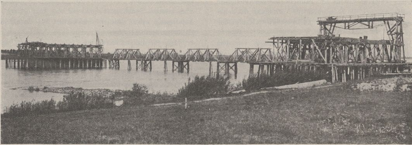
Abb. 10. Werksteg zwischen rechtsseitigem Strompfeiler und östlichem Ufer.
