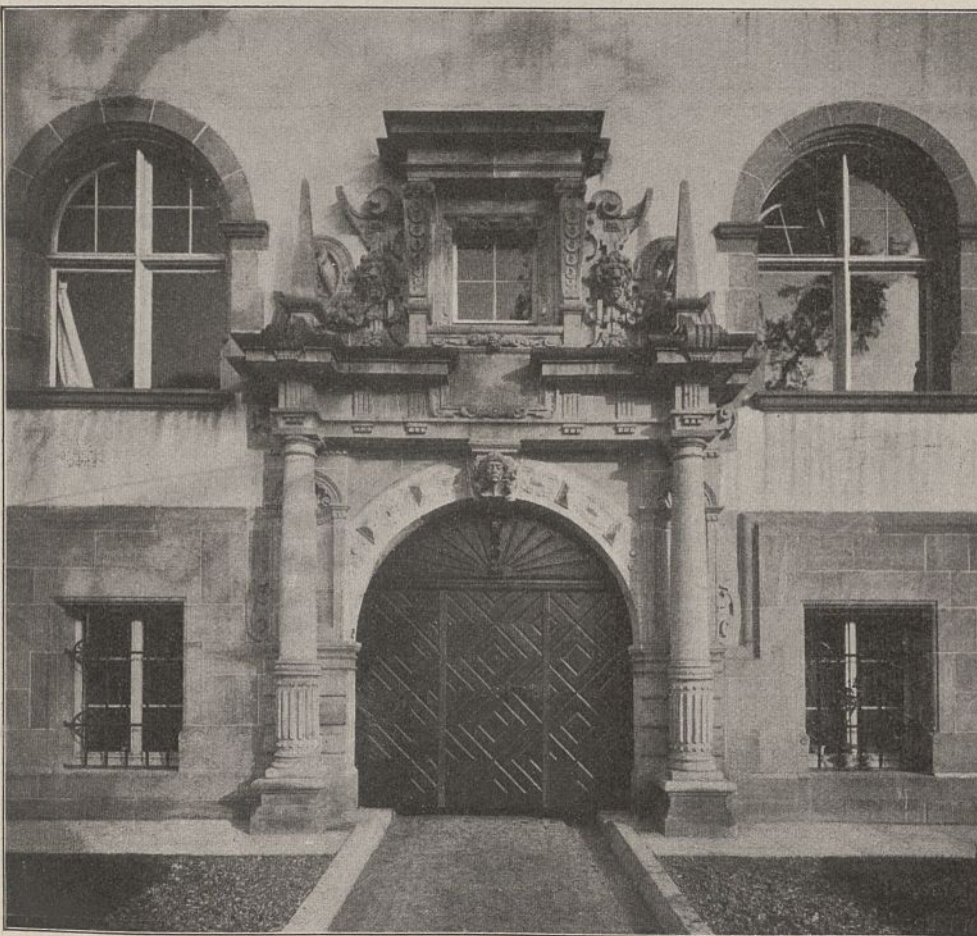
Abb. 12. Durchfahrtsportal auf der Westseite.
