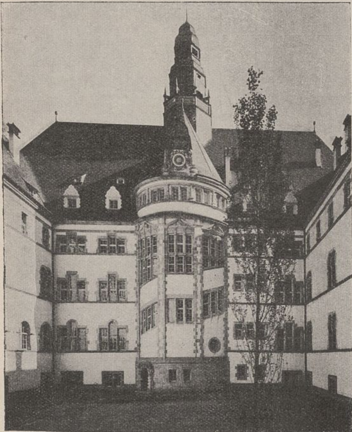
Abb. 6. Hofansicht mit dem Haupttreppenhaus.
