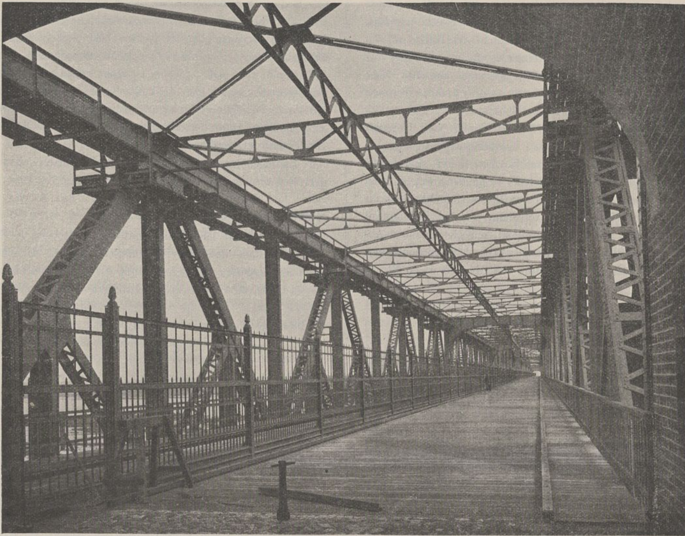
Abb. 13. Innenansicht der Brücke, Geländer und Trennungsgitter.
