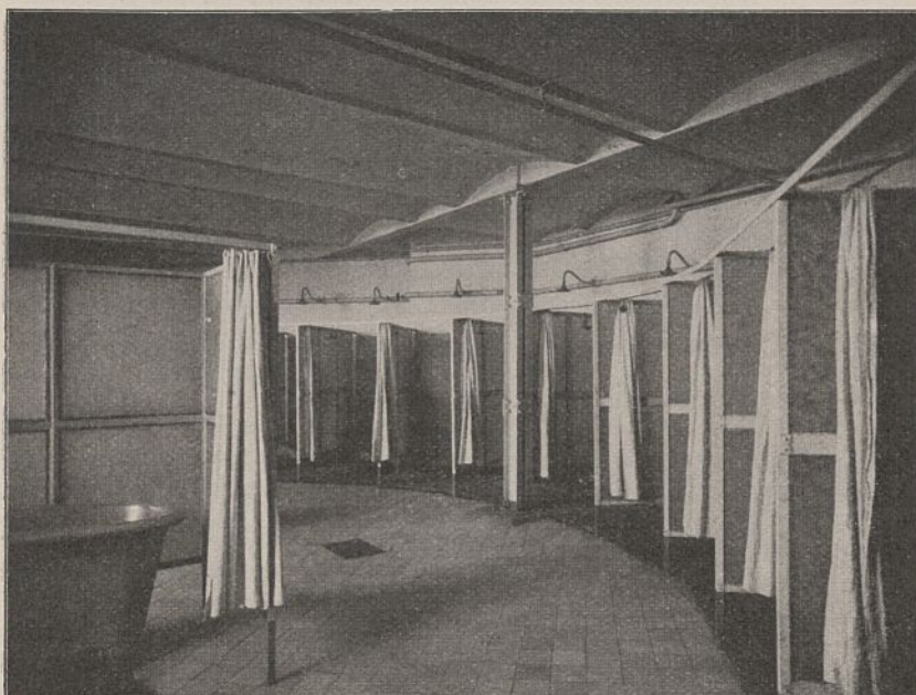
Abb. 20. Badeanlage im Erdgeschoß.
