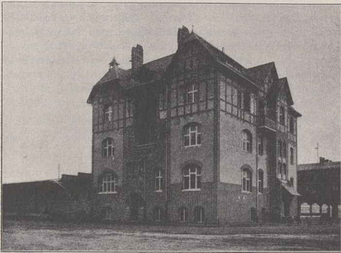
Abb. 41. Güter-Abfertigungsgebäude und Schuppen auf dem Ostbahnhof in Berlin.
