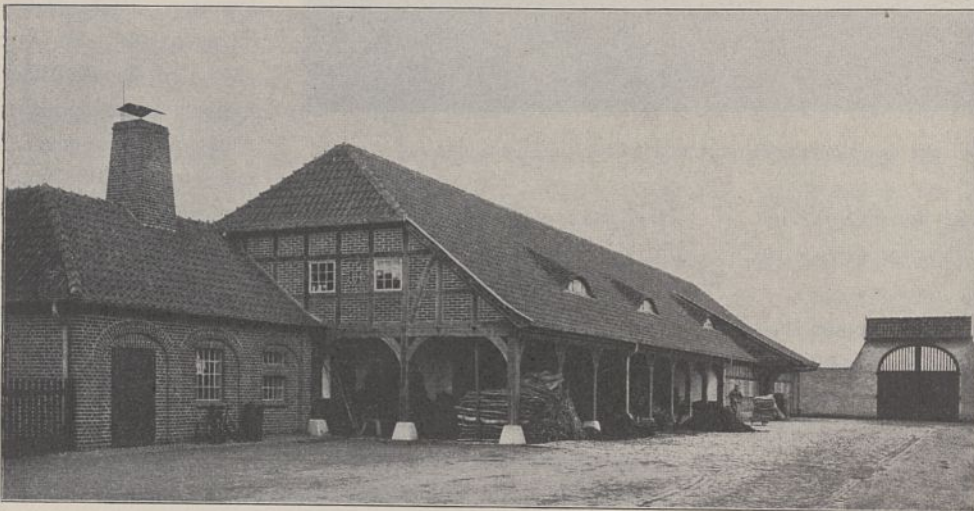
Abb. 14. Schuppen mit Schmiede und Ausfahrtstor nach den Ländereien.
