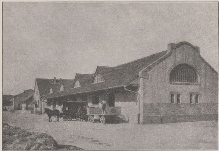
Abb. 5. Zollschuppen in Wiesbaden.
