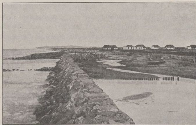
Abb. 1. Steinwall und Buhnen vor den Dörfern Neuendorf-Plogshagen auf Hiddensee.
