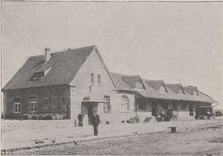
Abb. 4. Zollabfertigungsgebäude und Zollschuppen in Wiesbaden.
