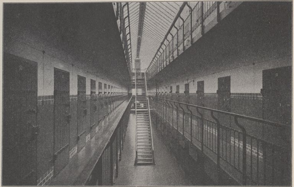
Abb. 9. Blick in den panoptischen Flur des Männergefängnisses.
