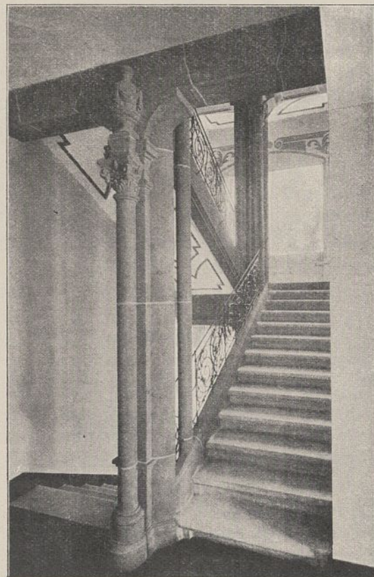
Abb. 22. Treppenhaus an der Ohlystraße.
