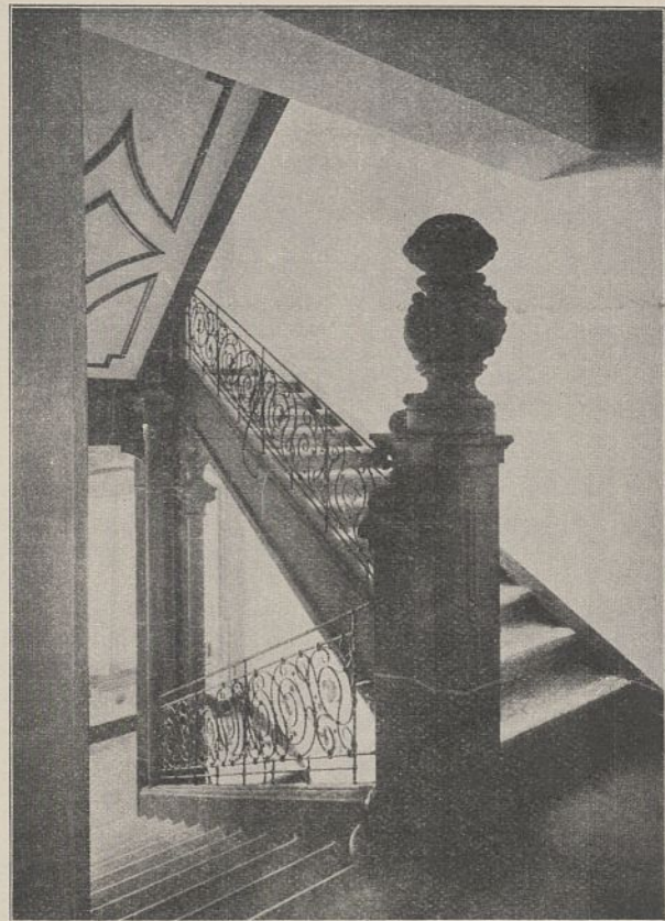
Abb. 20. Treppenhaus an der Ohlystraße.
