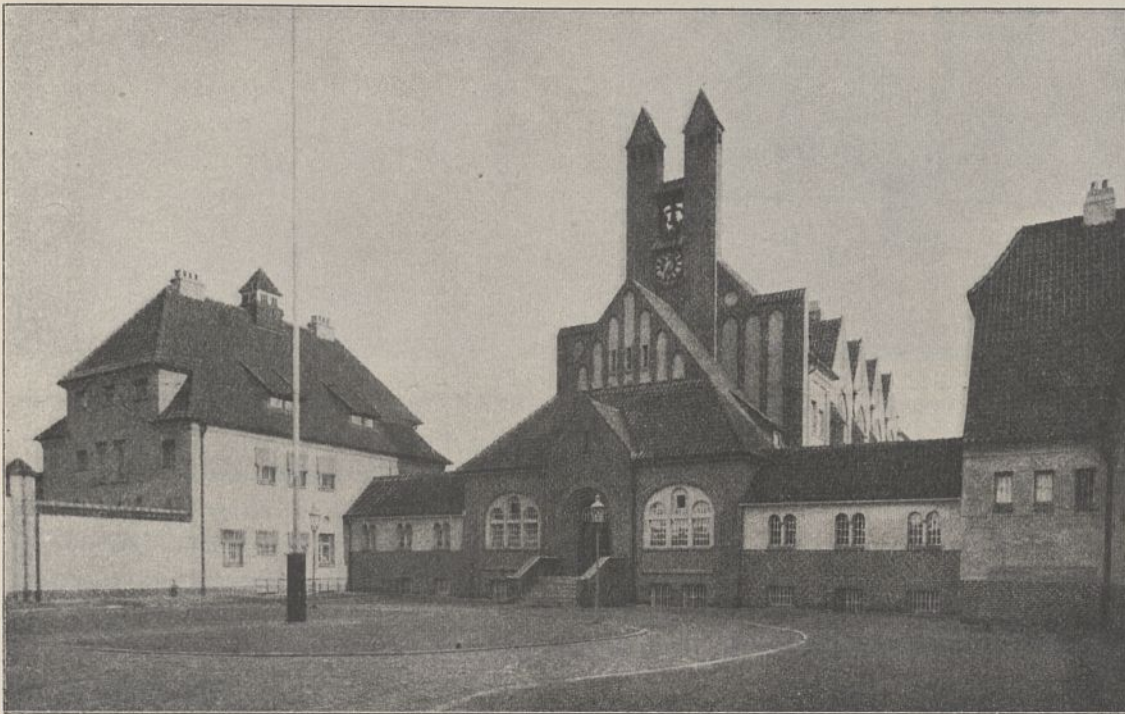
Abb. 3. Blick vom Vorhof auf das Weiberhaus und das Verwaltungsgebäude.
