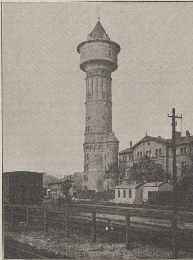
Abb. 1. Wasserturm auf dem Bahnhof Grunewald.
