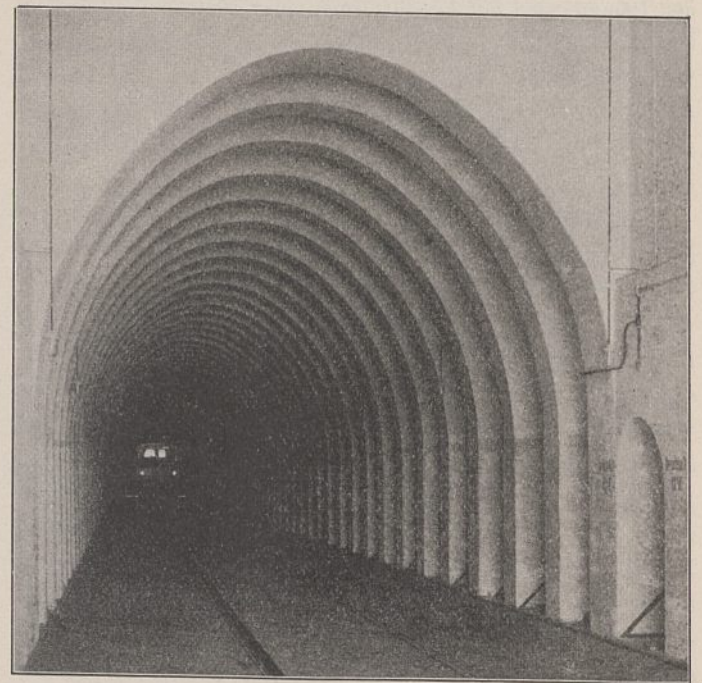
Abb. 2. Silotunnel für die ankommenden Eisenbahnwagen.
