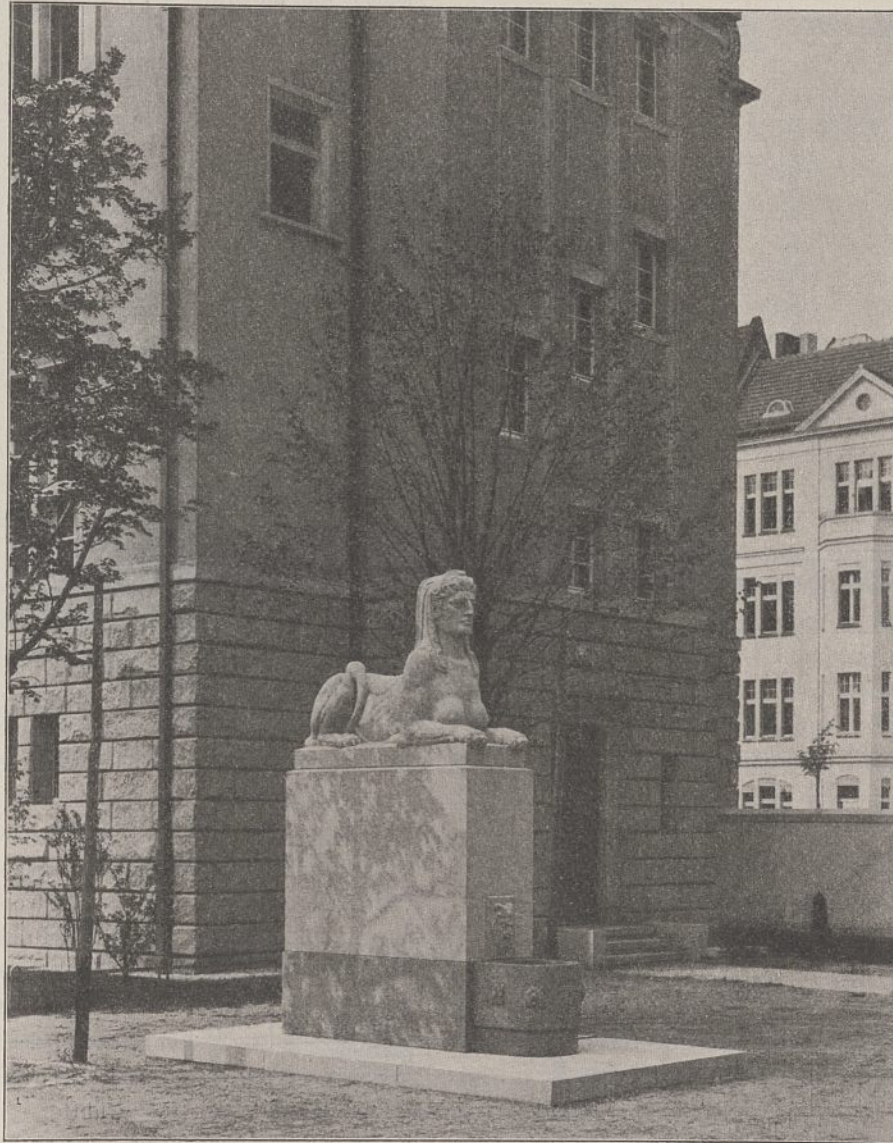
Abb. 21. Elektrotechnisches Institut. Ostseite des Längsflügels.
