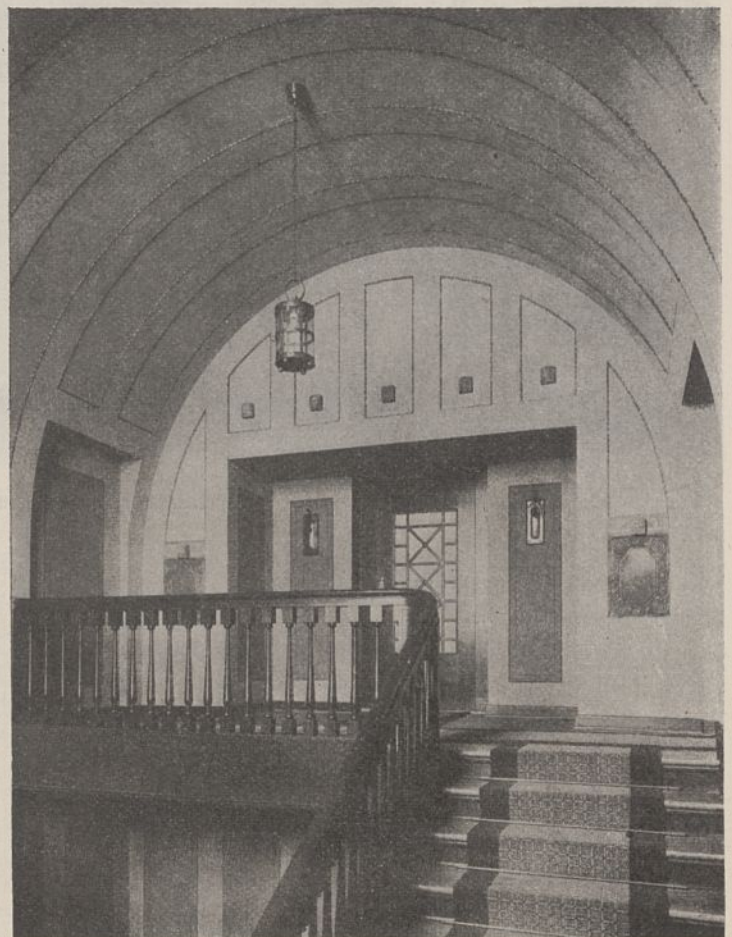
Abb. 9. Treppenhaus der Präsidentenwohnung.
