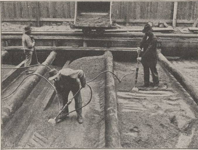
Abb. 86. Betonieren der Tunneldecke mit Druckluftstampfern.
