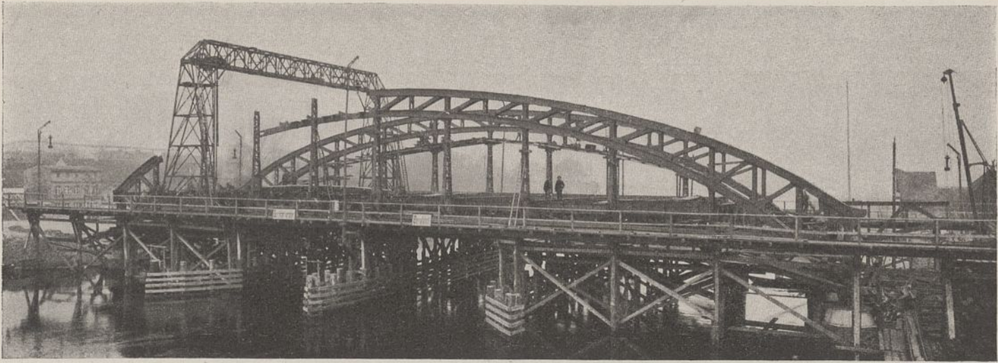
Abb. 18. Aufstellung des Überbaues der Mittelöffnung der Havelbrücke.
