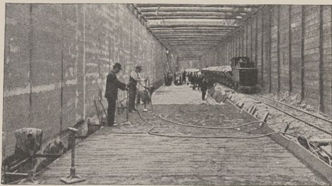
Abb. 83. Stampfen des Betons mit Druckluftstampfern.
