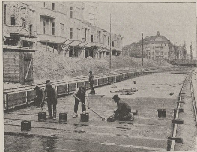
Abb. 87. Aufbringen der Dichtung auf die fertig betonierte Tunneldecke.
