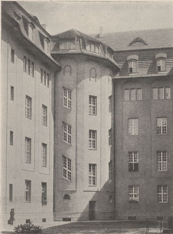
Abb. 11. Treppenhaus und Hofansicht des Flügels am Horstweg.
