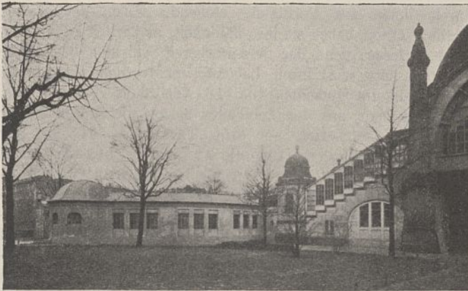
Abb. 43. Verbindungsgang zwischen der vorläufigen Haltestelle am Nollendorfplatz und der Hochbahn.
