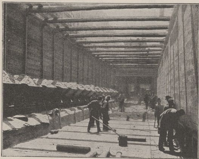
Abb. 84. Aufbringen der dreifachen Dichtung der Tunnelsohle auf die wagerechte Betonunterlage.
