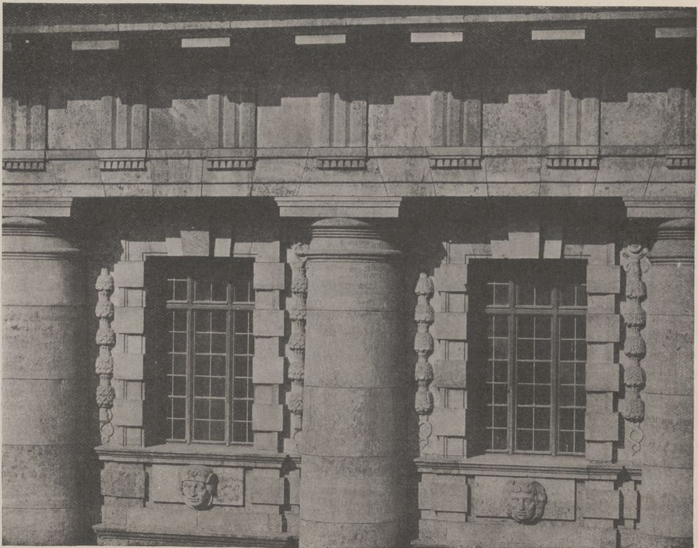
Abb. 8. Vom Mittelbau an der Jüdenstraße.
