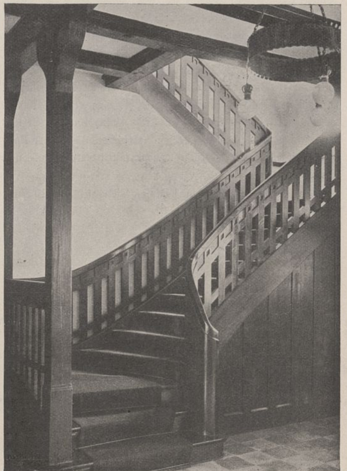
Abb. 9. Direktorwohnhaus. Treppe in der Diele.
