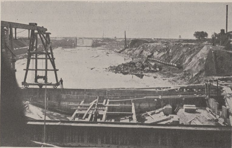
Abb. 15. Bau der Sperrschleuse. 1882/83.
