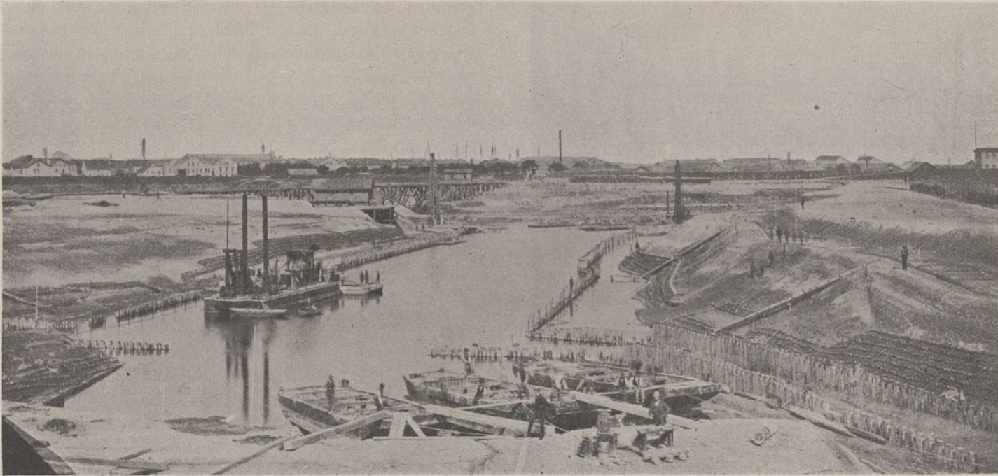
Abb. 11. Bau der neuen Seeschleuse in Wilhelmshaven (aufgen. 28. Sept. 1878).
