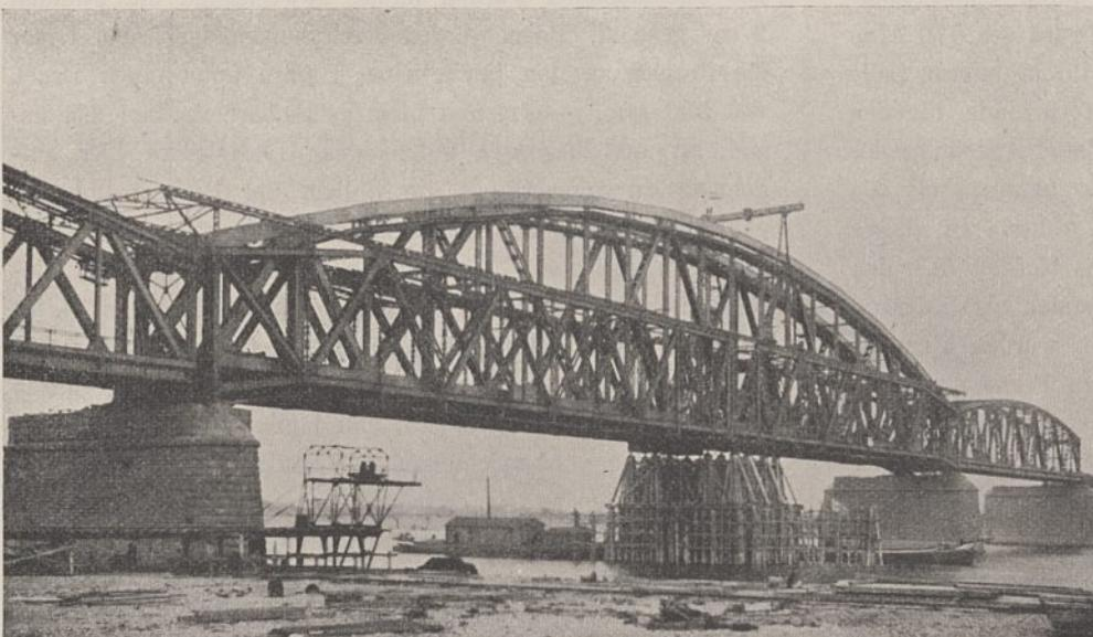
Abb. 72. Fertig aufgestellter, großer Stromüberbau auf den Rüstträgern.
