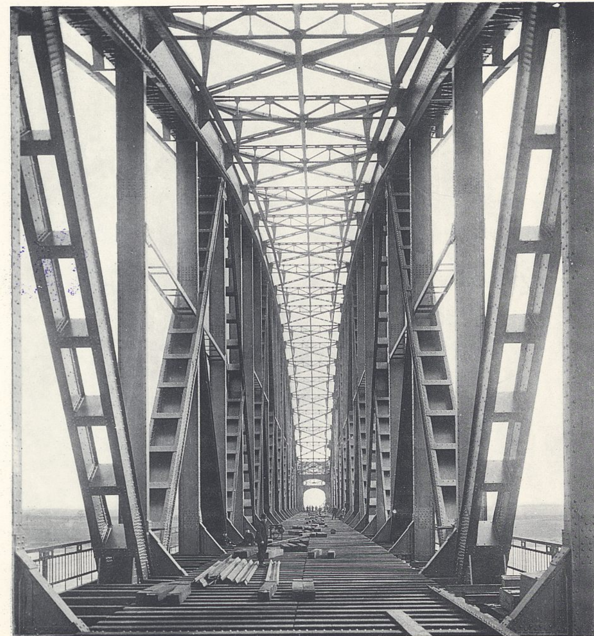
Abb. 3. Blick in den fertigen großen Überbau.
