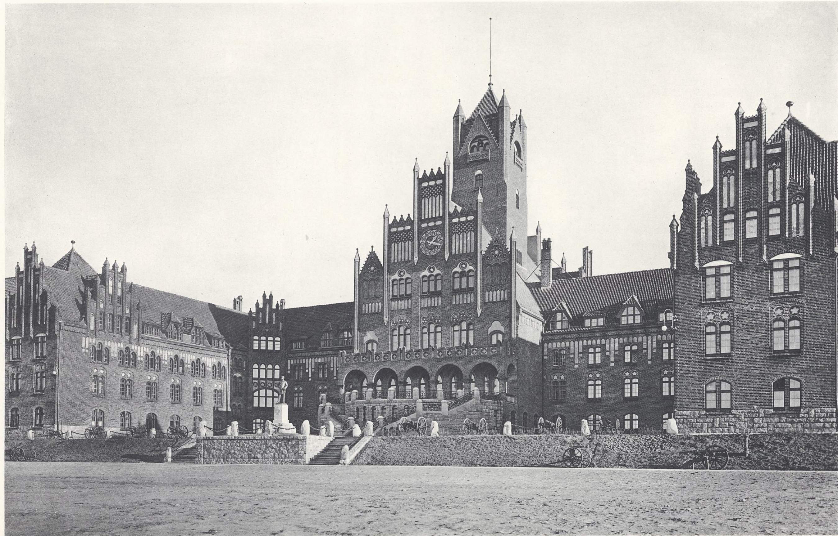
Ansicht des Mittelbaues von der Wasserseite.
