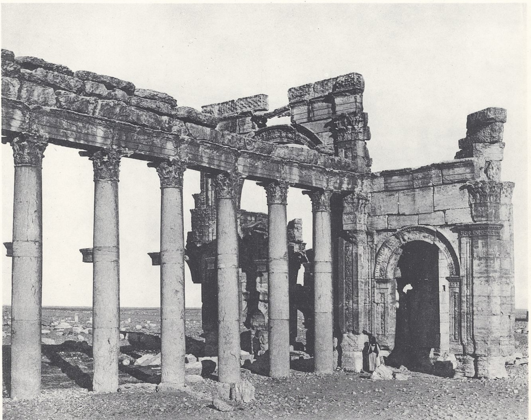
Abb. 2. Säulentor am Straßenknie, Ansicht von Westen.
