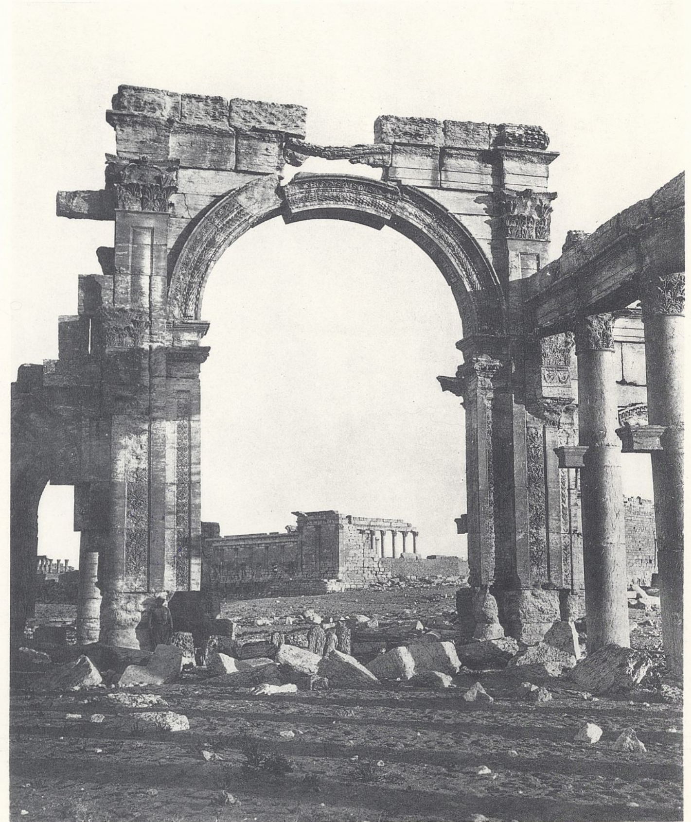
Abb. 2. Mittlerer Bogen des Straßentors
