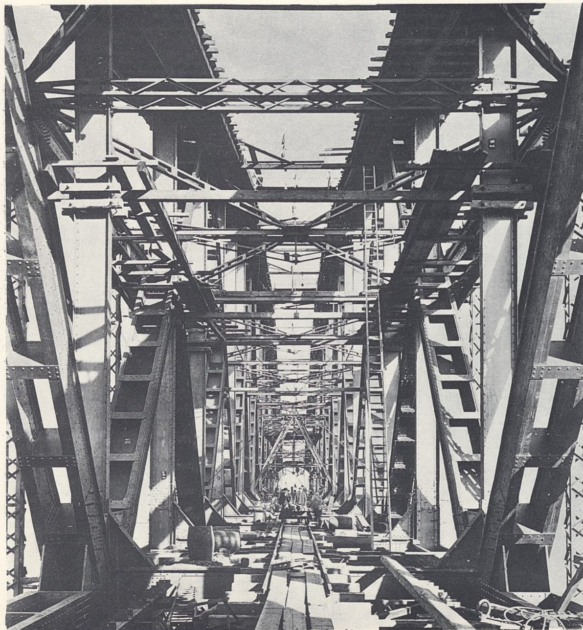
Abb. 2. Blick in die Rüstträger während der Aufstellung des Überbaues.
