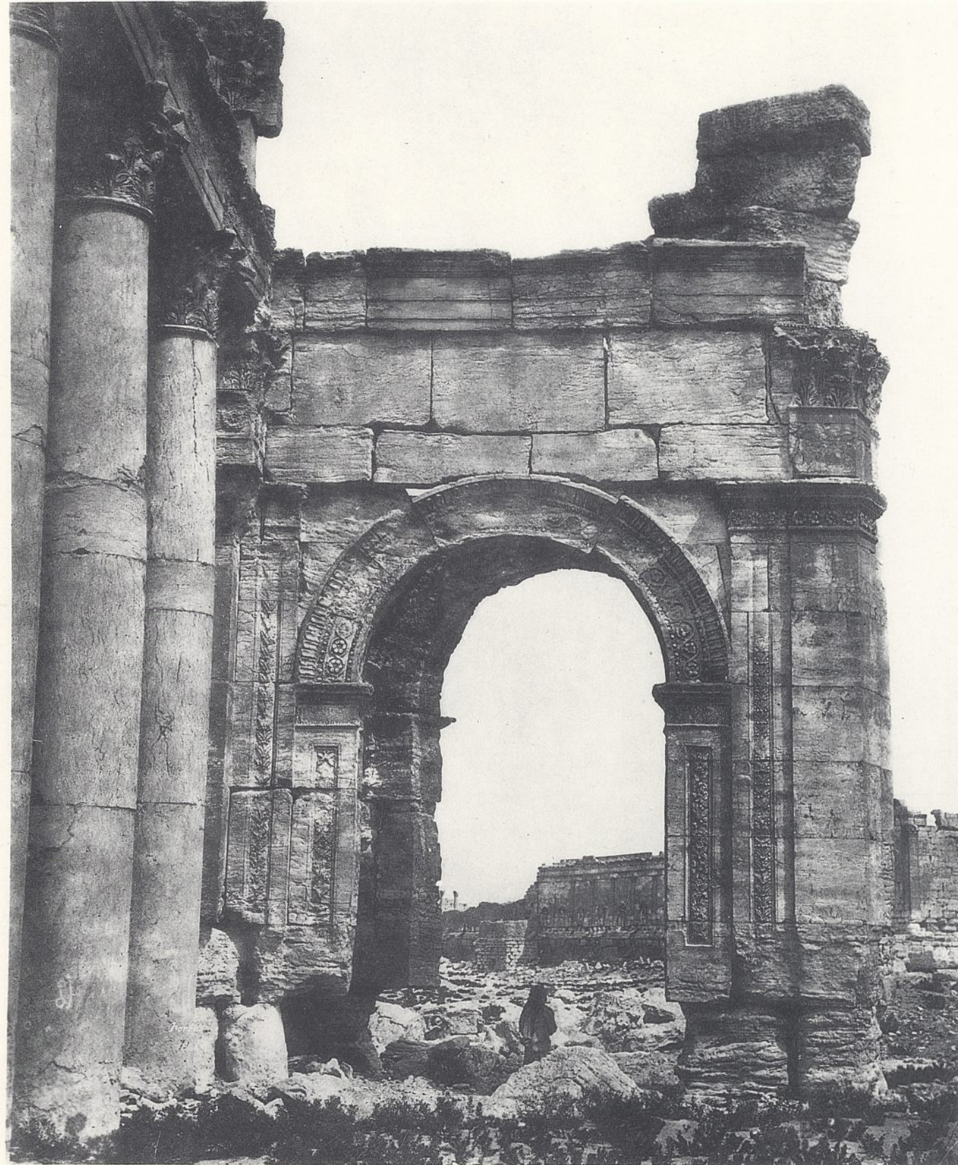
Abb. 1. Seitlicher Durchgang des Straßentors
