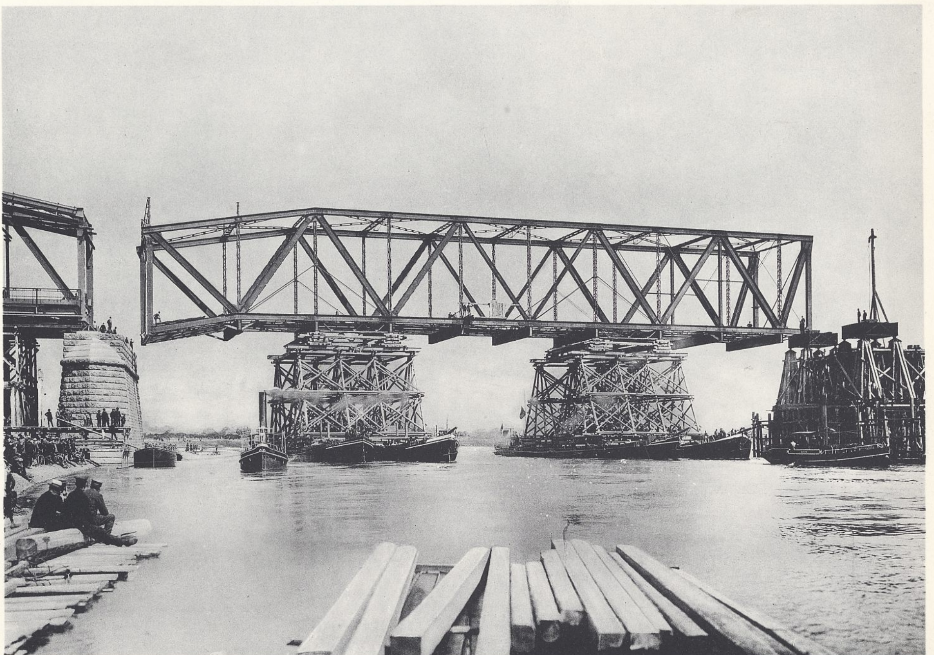
Abb. 2. Ankunft des Rüstträgers auf der Baustelle.
