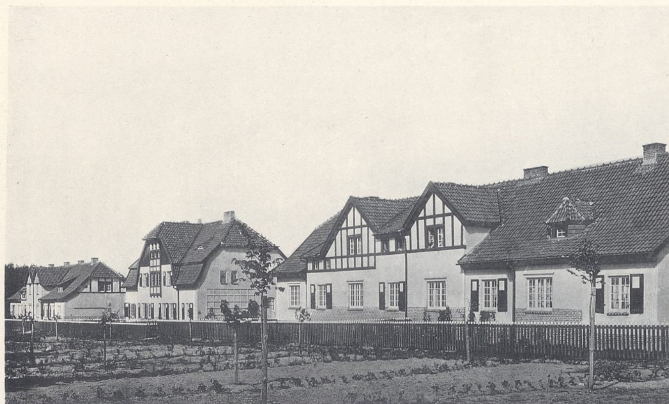
Abb. 1. Vierfamilienhaus 1, Dreifamilienhaus und Vierfamilienhaus 3.
