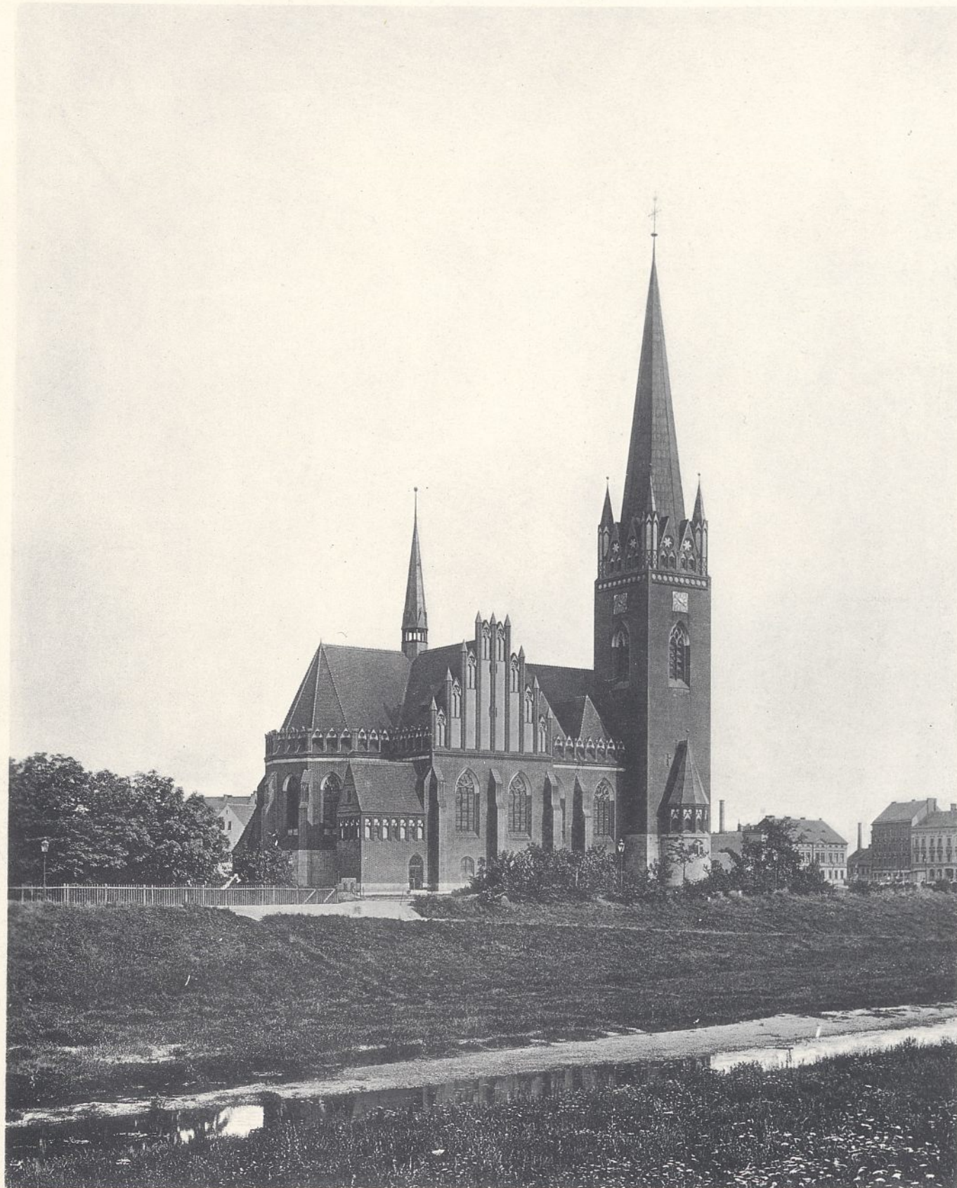
Abb. 1. Ansicht von Nordwesten.
