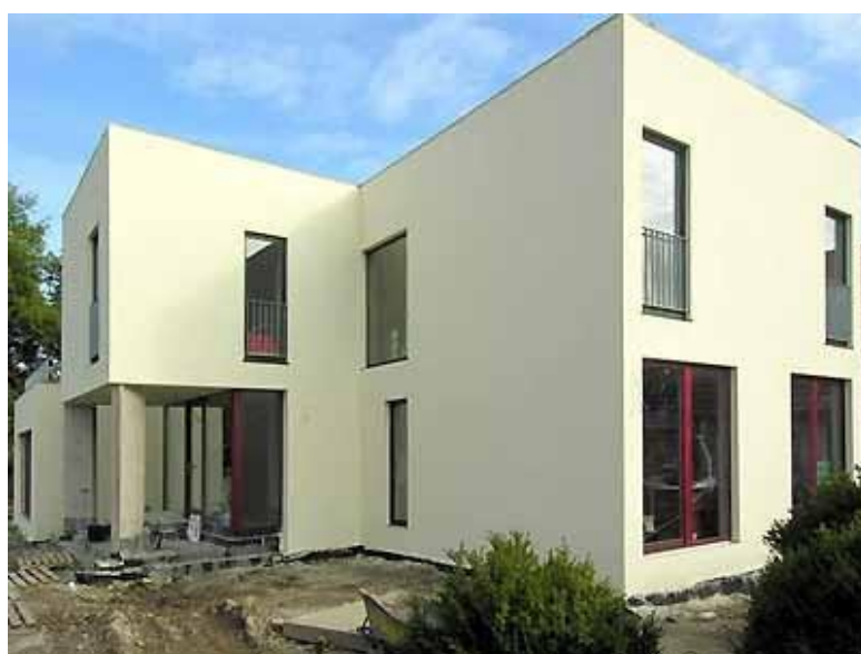
Fot. 38 – 39. Budowa domu jednorodzinnej z wielkiej płyty z odzysku w Schildow– Niemcy [261].
