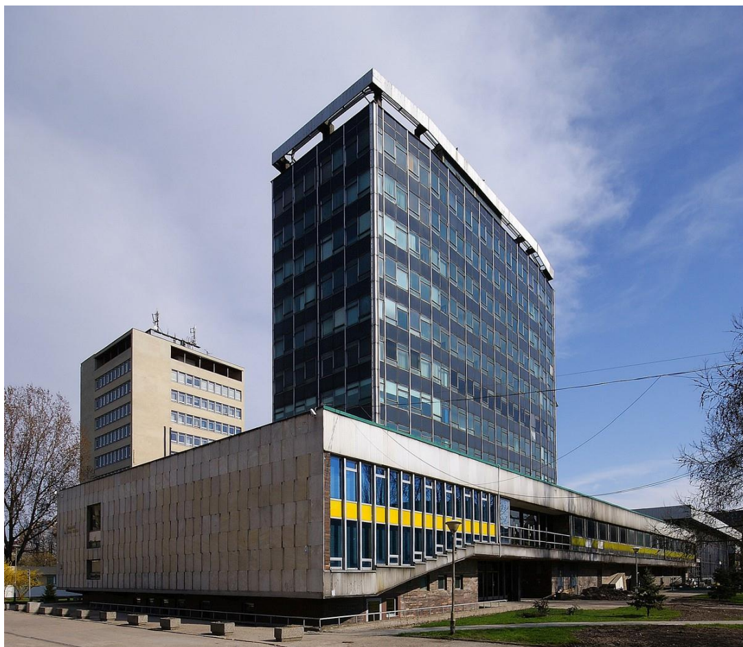
Fot. 44. Budynek C – 9, Politechnika Wroclawska [260].
