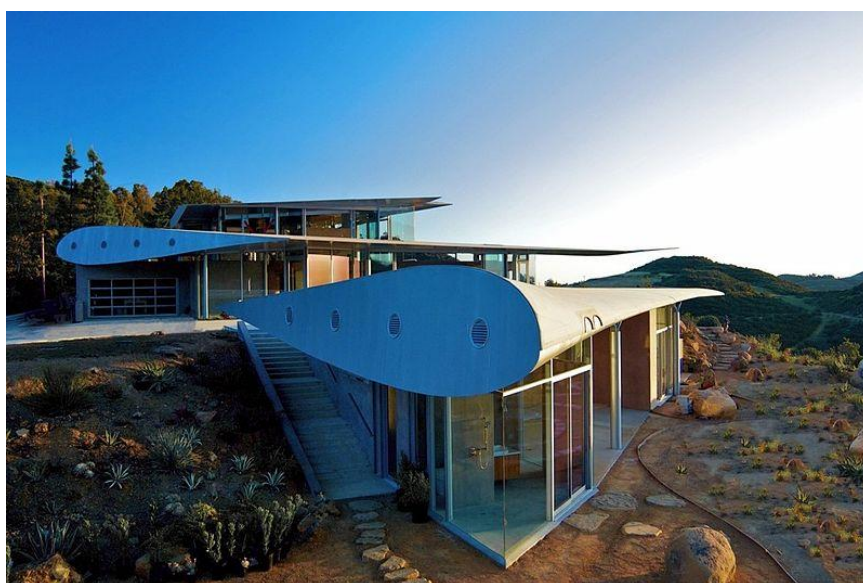
Fot. 29. 747 Wing House w Malibu – USA [9].
