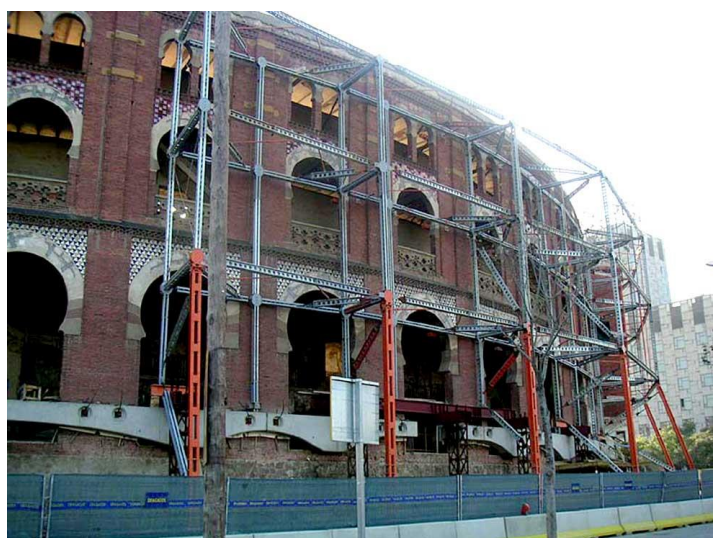
Fot. 72 – 75. Przebudowa areny miejskiej na centrum handlowe, Barcelona. Projekt obejmował czasowe podwieszenie ścian zewnętrznych, ich podcięcie i osadzenie na nowej konstrukcji nośnej, projekt: Rogers Stirk Harbour + Partners [256].
