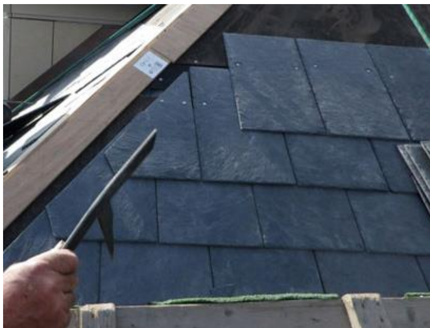
Fot. 64. Przykład zastosowania gwoździ do mocowania pokrycia dachowego z łupka. Fot. autora.
