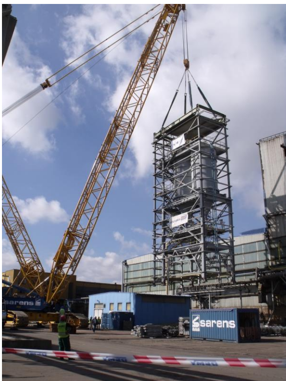
Fot. 62 – 63. Zdjęcia z przebiegu robót przy realizacji inwestycji przesunięcia i modernizacji budynku sody i wapna na terenie Huty Miedzi Głogów. Fot. autora.
