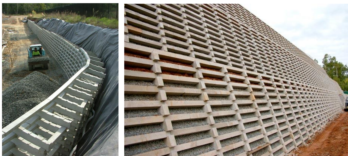
Fot. 48 – 49. Ściana oporowa typu crib wall [208].
