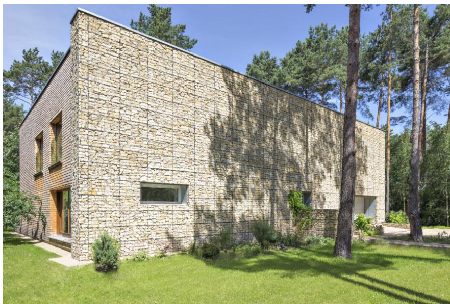
Fot. 50. Okładzina elewacyjna z gabionów. Willa w Izabelinie Północnym koło Warszawy autorstwa Biura Architektonicznego Barycz i Saramowicz [122].
