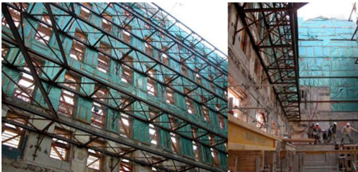
Fot. 67 – 68. Wewnętrzne podłużnice kratowe wzmacniające masywną ścianę osłonową [51].
