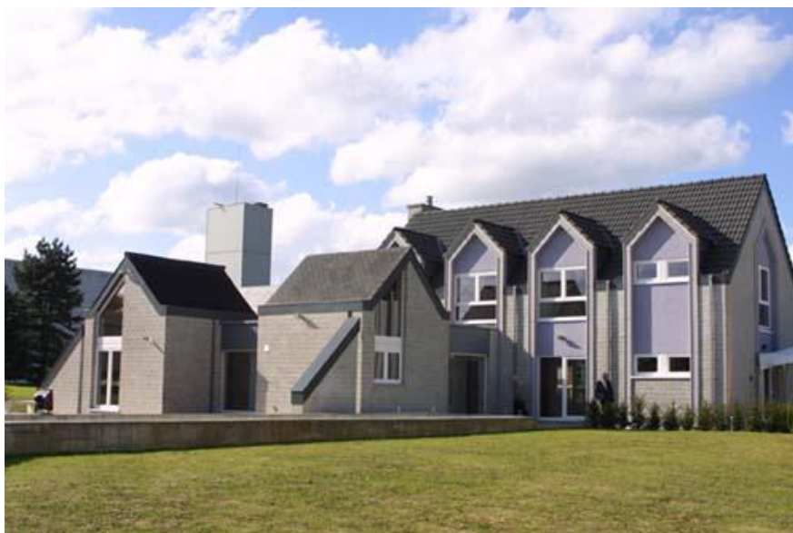
Fot. 43. RECYhouse , Limelette pod Brukselą [255].
