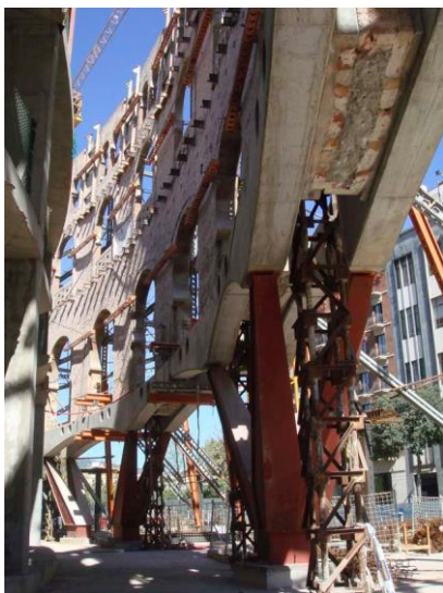
Fot. 72 – 75. Przebudowa areny miejskiej na centrum handlowe, Barcelona. Projekt obejmował czasowe podwieszenie ścian zewnętrznych, ich podcięcie i osadzenie na nowej konstrukcji nośnej, projekt: Rogers Stirk Harbour + Partners [256].
