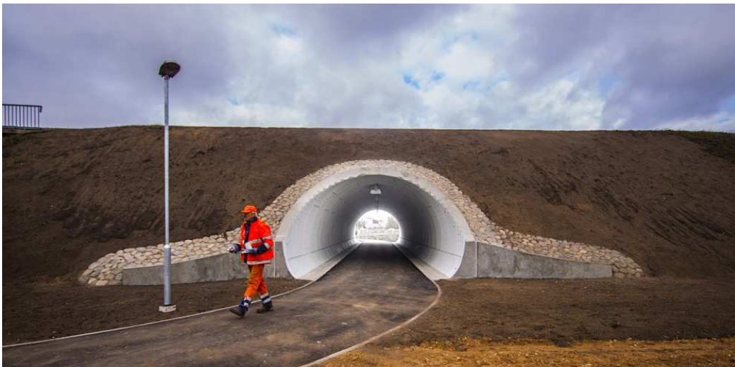
Rys. 1.1. Obiekt mostowy o konstrukcji gruntowo-powłokowej pod linią kolejową; źródło fotografii: http://viacon.pl/pl/konstrukcje-multiplate#
