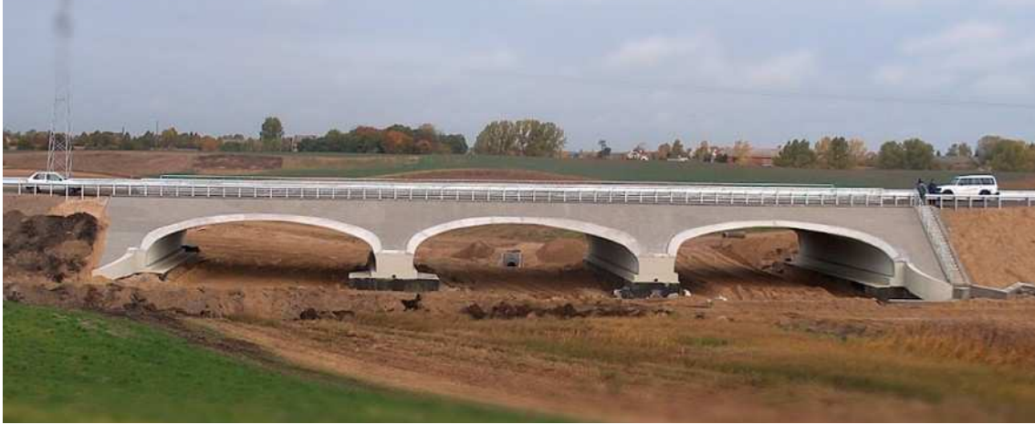
Rys. 2.3. Trzyprzęsłowy most gruntowo-powłokowy w ciągu obwodnicy Gniezna; źródło fotografii: http://viacon.pl/pl/konstrukcje-supercor
