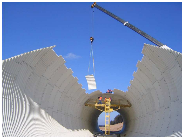
Rys. 2.2. Powłoka MultiPlate podczas montażu; źródło fotografii: http://viacon.pl/pl/konstrukcje-multiplate
