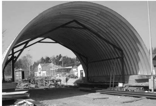
Rys. 2.27. Powłoka mostu kolejowego na trasie Malmo-Ystad (Szwecja) [15]
