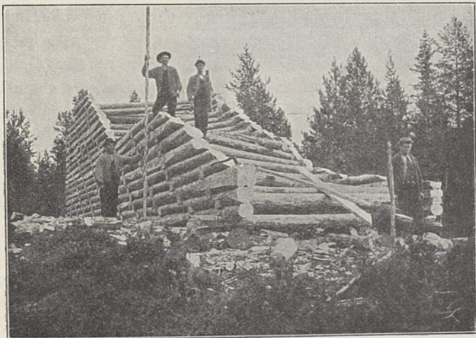
Abb. 6. Steinkistenbau.
