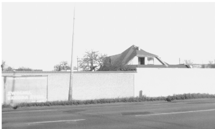
Fot. 3. Murowane ogrodzenie o różnej wysokości i sposobie wykończenia
