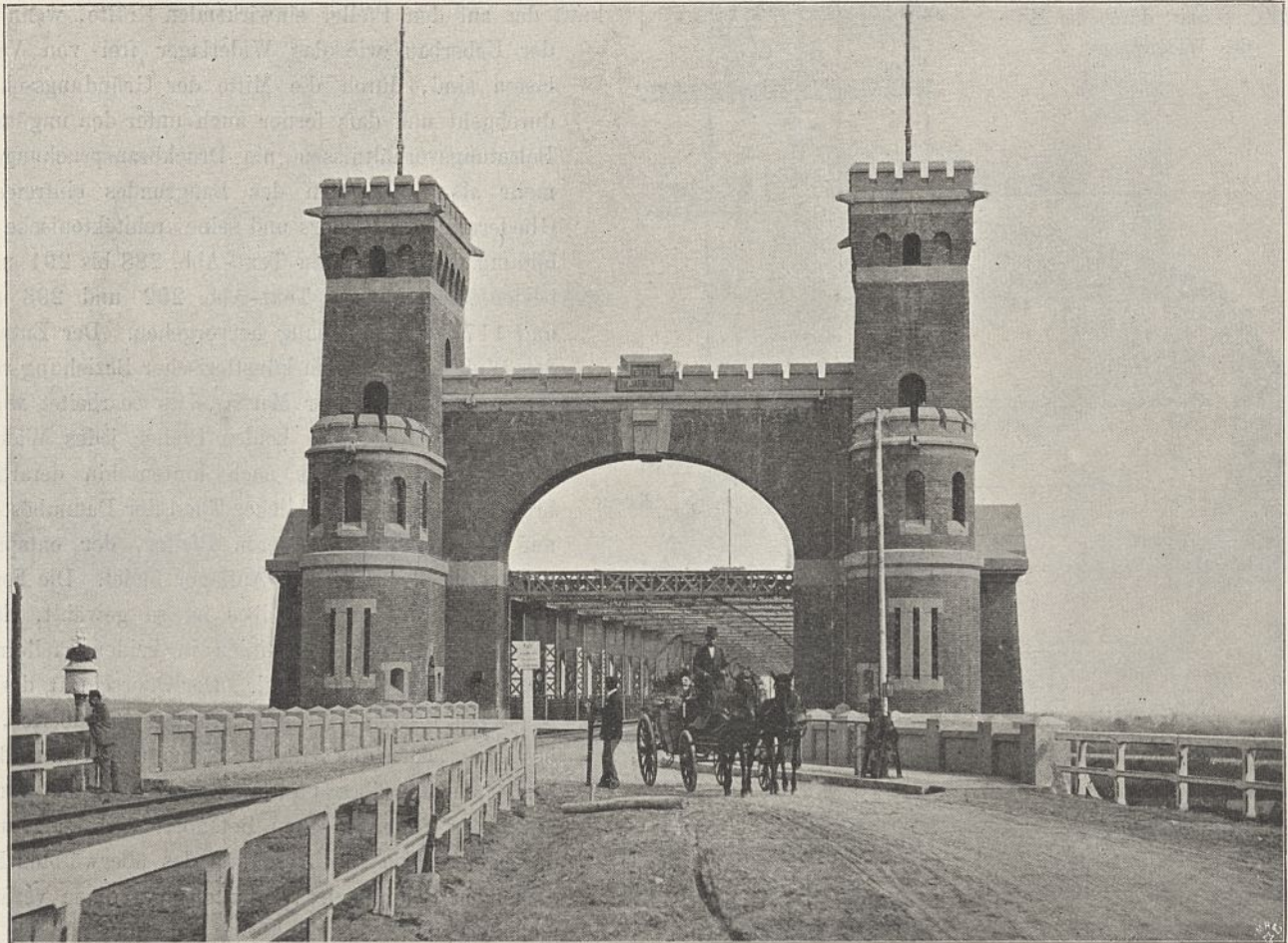
Abb. 292. Hochbrücke bei Levensau.
