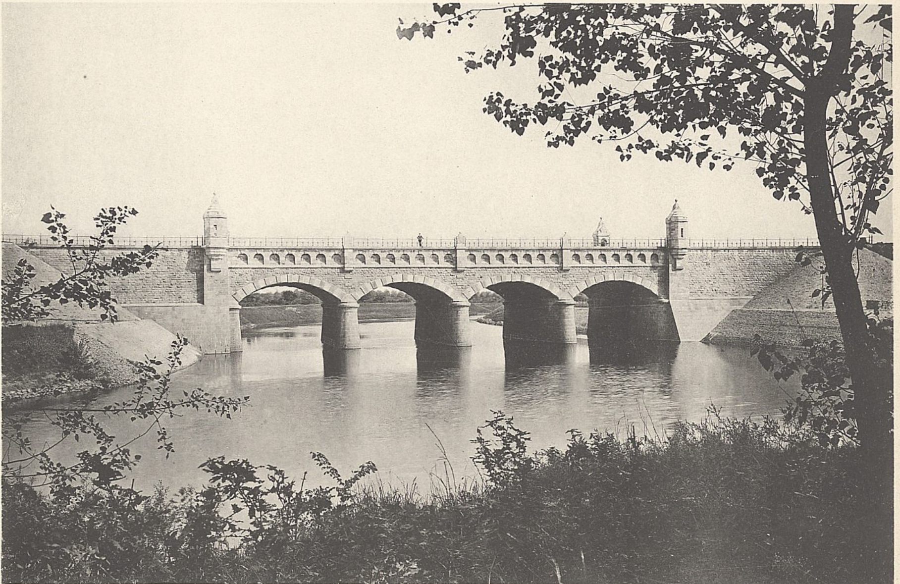
Abb. 2. Brückencanal über die Ems.
