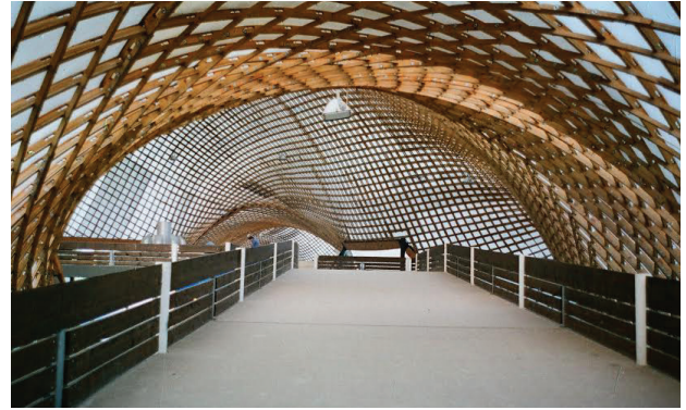
Il. 4. Hala wystawowa w Mannheim. Wnętrze (1978) (fot. T. Barucki)
