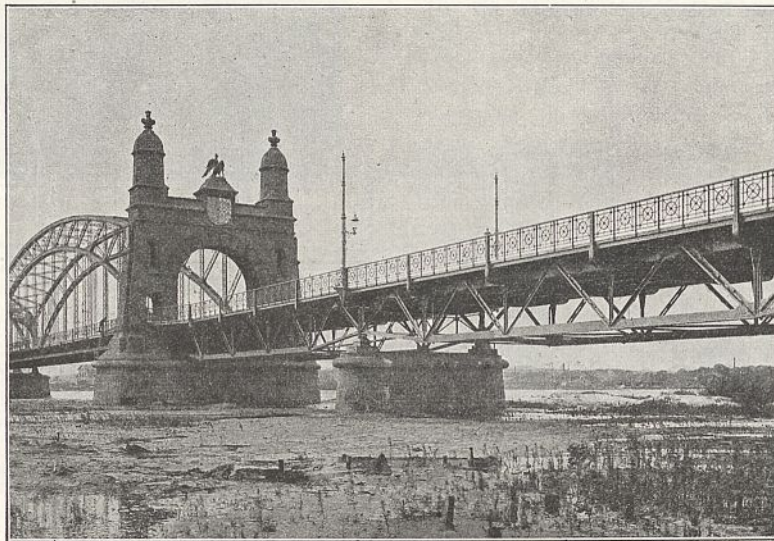
Abb. 16. Ansicht der Fluthbrücken.
