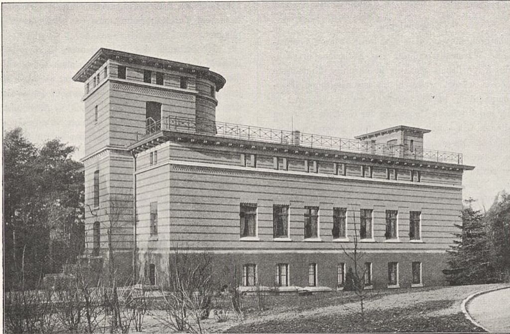
Abb. 14. Beamtenwohnhaus mit der Heliostatenanlage. Ansicht von Südosten.
