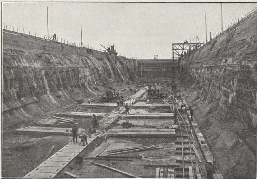
Abb. 19. Beginn der Maurerarbeiten für den Ausbau der Dockkammer V.
