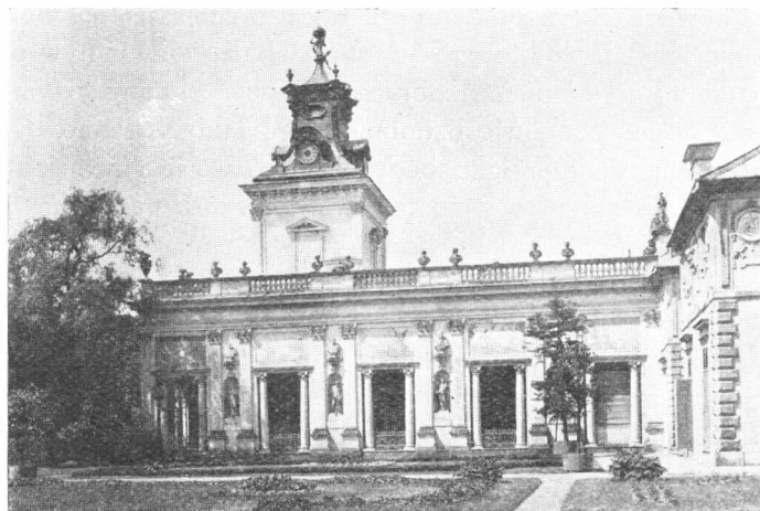
Ryc. 10. Wilanów. Widok galerji pałacowej od strony parku.
