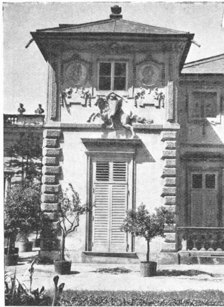
Ryc. 20. Wilanów. Narożnik w głównym korpusie pałacu od strony parku.
