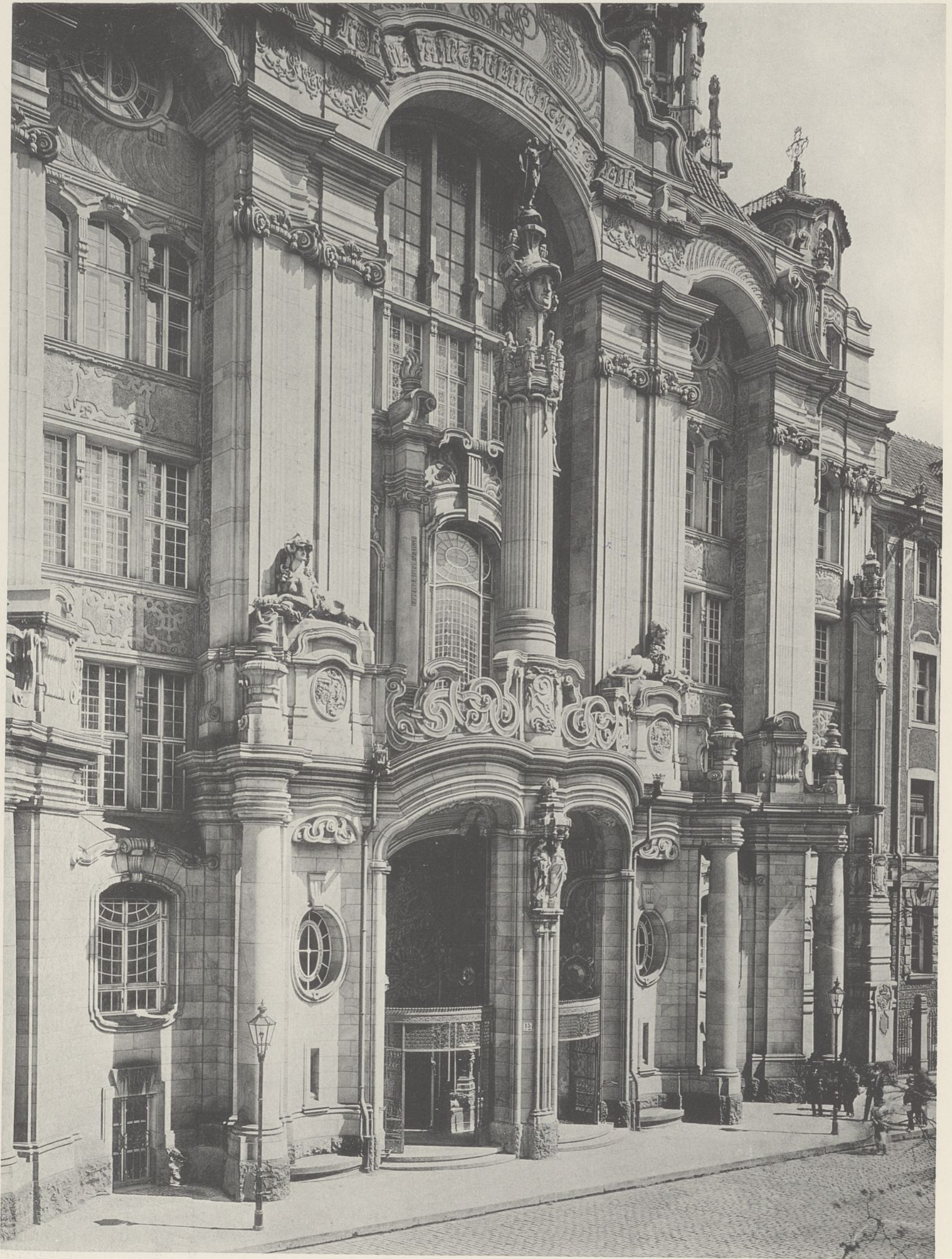
Mittelbau des Amtsgerichts in der Neuen Friedrichstraße.
