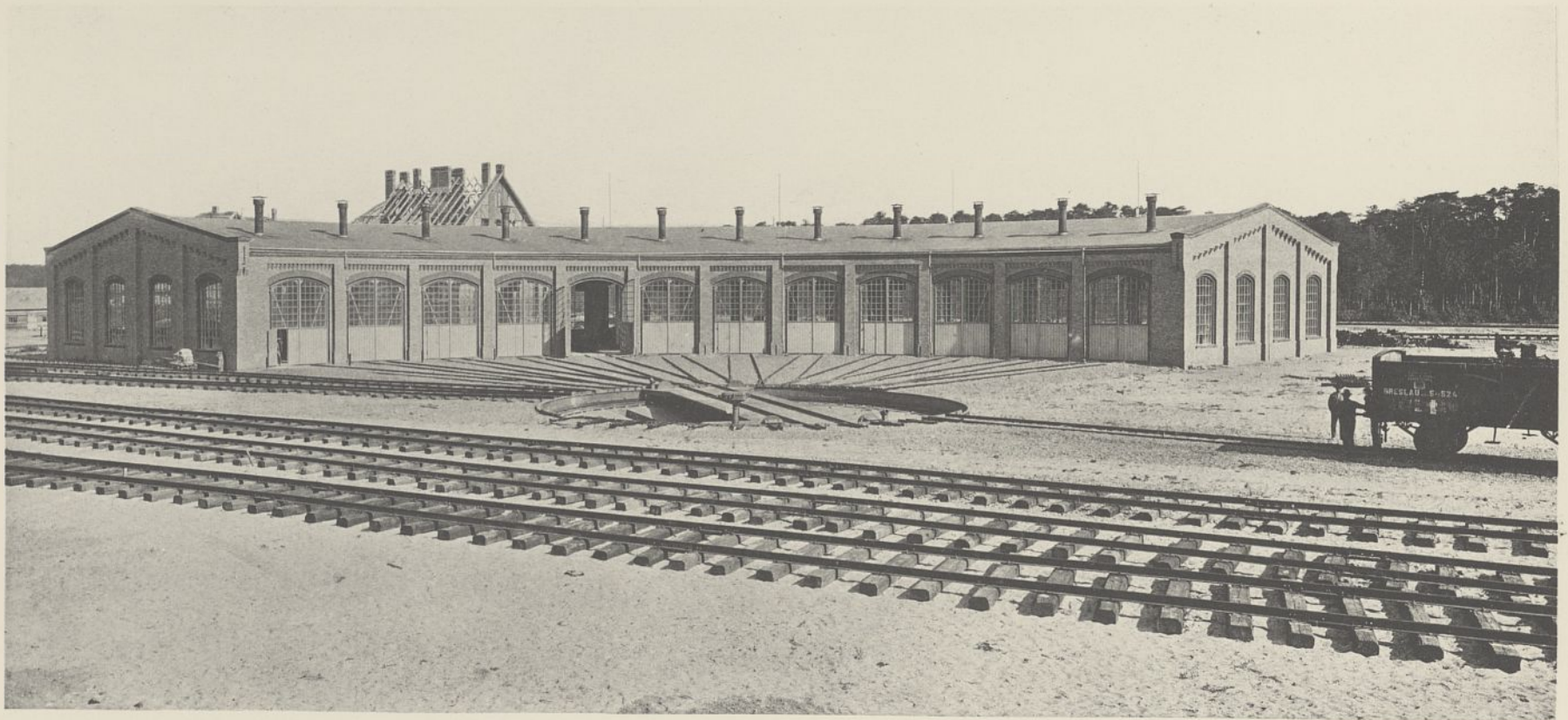
Abb. 2. Verschiebbahnhof Niederschöneweide. Lokomotivschuppen.
