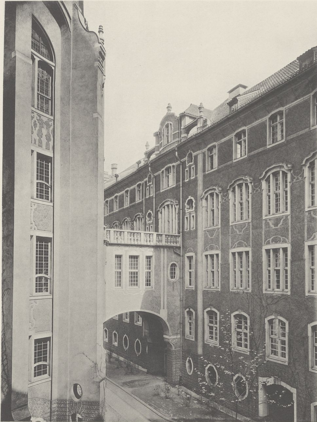
Abb. 1. Blick in den Hof III des Landgerichts.
