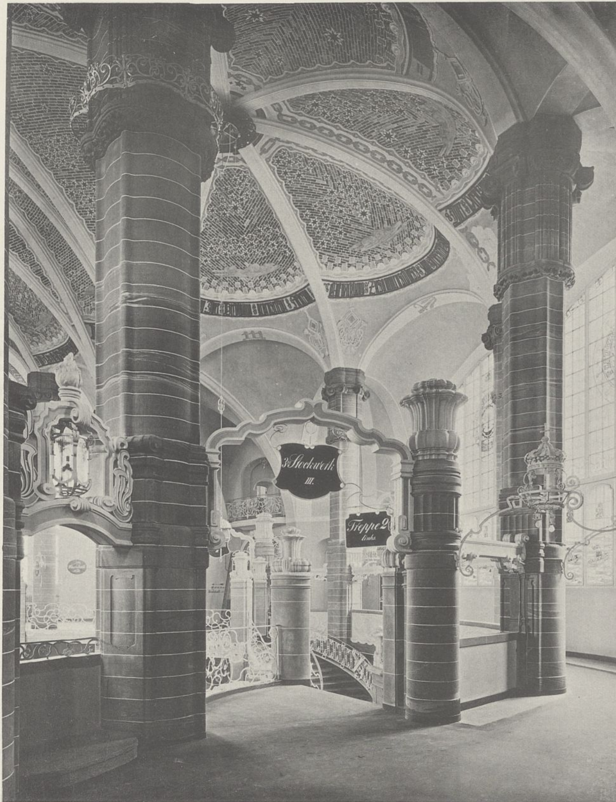
Abb. 1. Drittes Stockwerk der Treppenhalle des Amtsgerichts in der Neuen Friedrichstraße.
