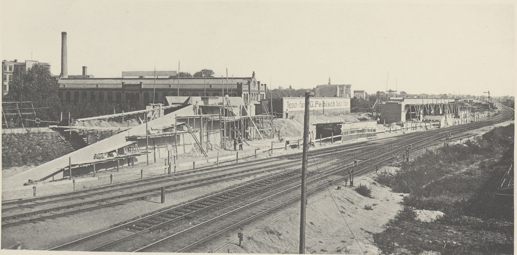
Abb. 3. Bau der schiefen Überführung der beiden Güterverbindungsgleise nach Treptow über die Görlitzer Personengleise.
