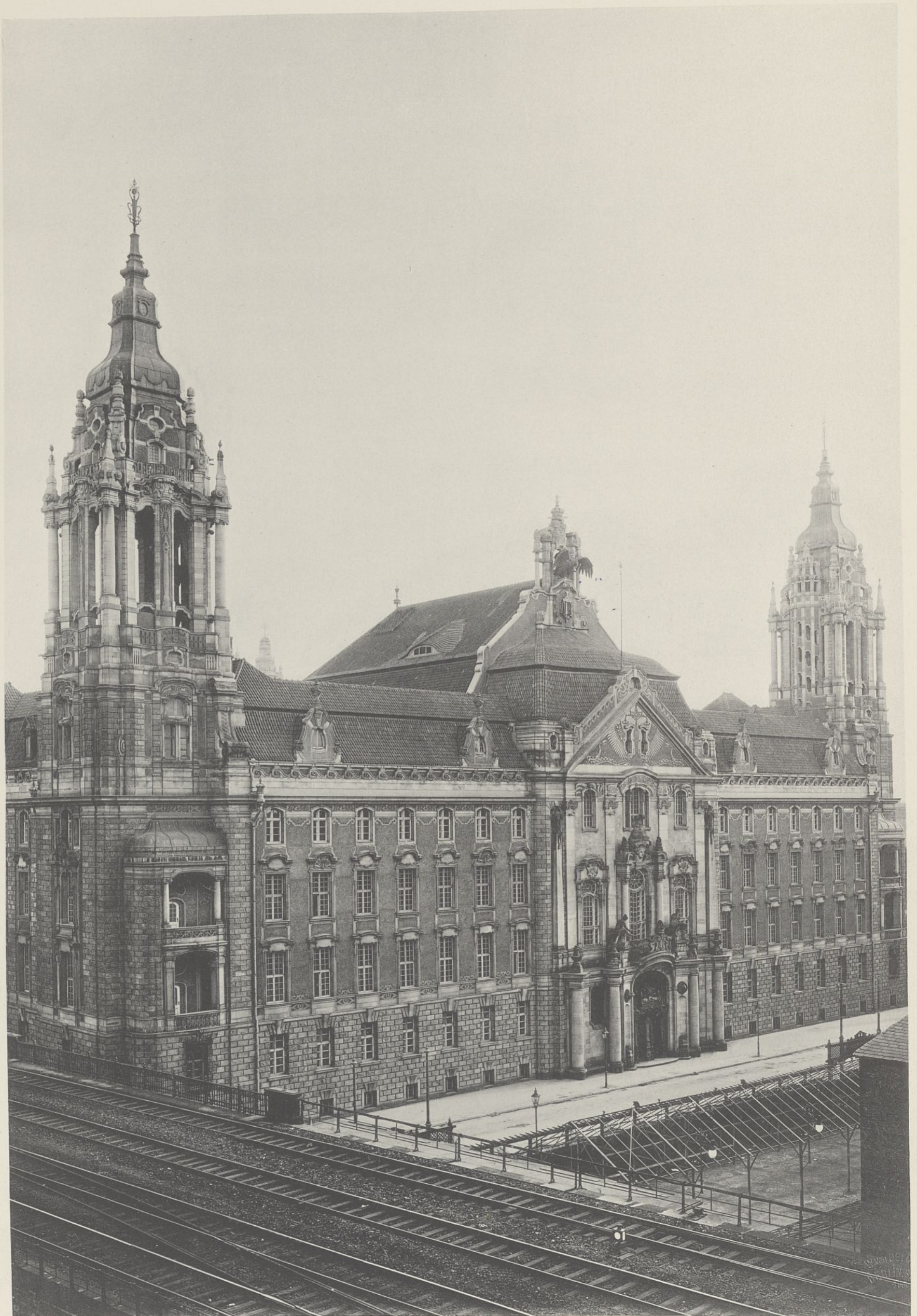
Ansicht von Norden. Front an der Grunerstraße.
