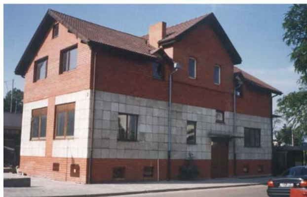
Fot. 1.3. Przykłady budownictwa z gipsu we Wrocławiu: a) ściany budynku słupowo-płytowego wypełnione pustakami typu KR, b) ściany mieszane ceglano-gipsowe, Wrocław Kuźniki. Fot. S. Klin
