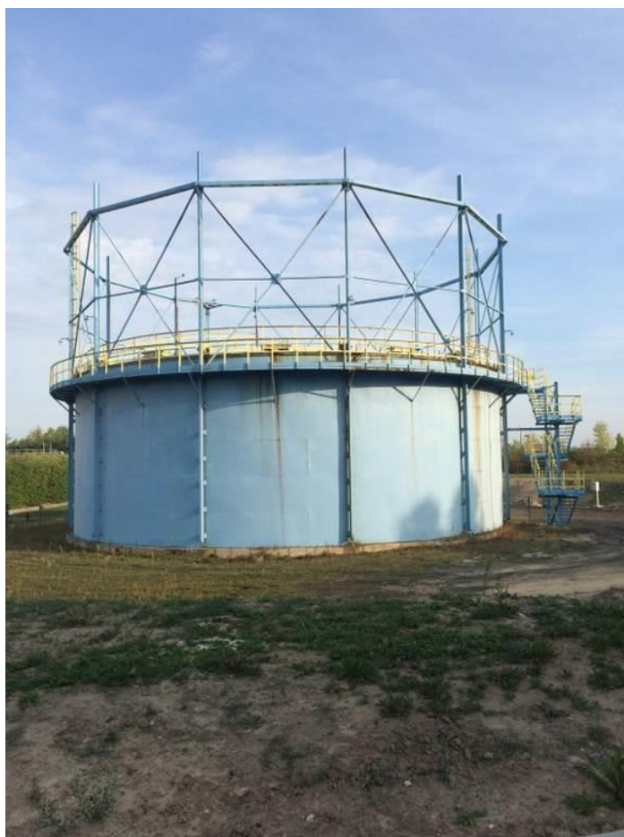
Rys. 2. Zbiornik gazu stalowy z uszczelnieniem wodnym w białostockiej oczyszczalni ścieków
