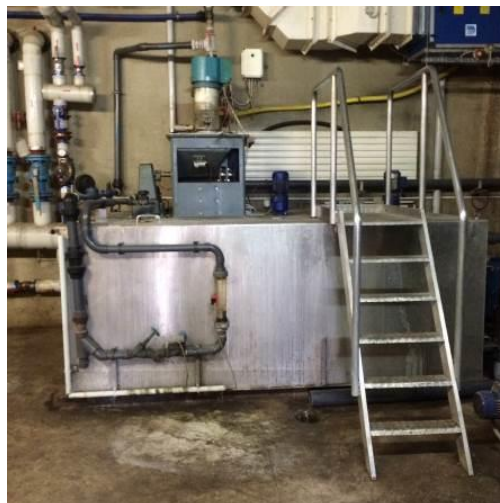
Rys. 6. Urządzenie do roztwarzania i dawkowania flokulantu
