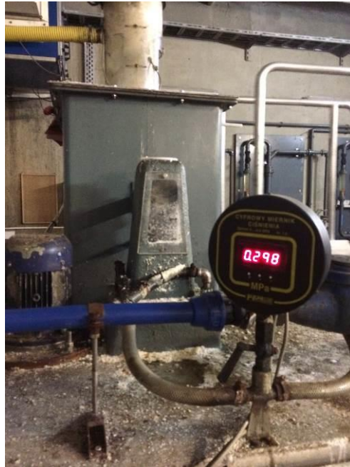
Rys. 5. Miejsce dozowania flokulantu
