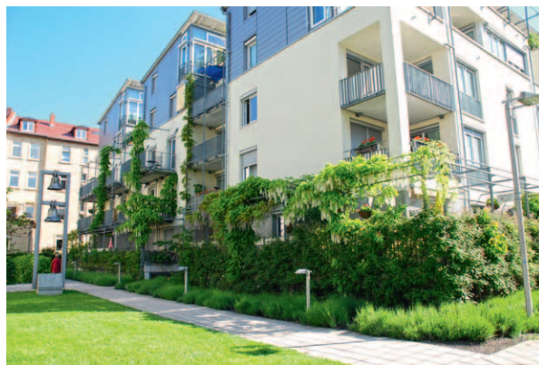
Ryc. 13. Glicynia ( Wisteria sp.) w odmianie rozpięta na tarasach, balkonach w przestrzeń publicznej osiedla mieszkaniowego w zabudowie wielorodzinnej (Heidelberg – Niemcy) 2013 r.
