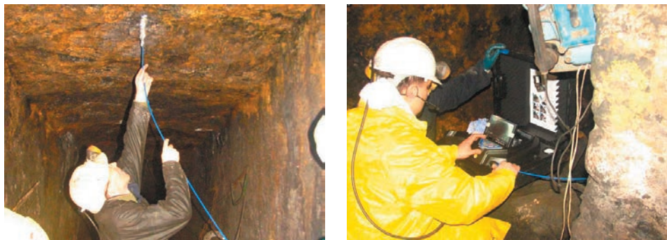
Ryc. 8 Badania struktury górotworu w otoczeniu wyrobiska przy użyciu wideoendoskopu prowadzone w Głównej Kluczowej Sztolni Dziedzicznej w Zabrze
