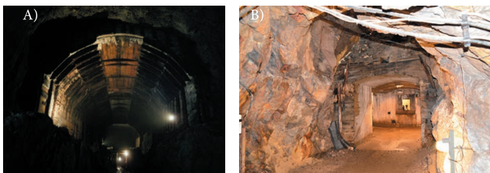
Ryc. 2. A) Niedokończona hala z pozostawionymi szalunkami – obiekt „Osówka”; B) wejście do wartowni w sztolni nr 1 – obiekt „Rzeczka”
