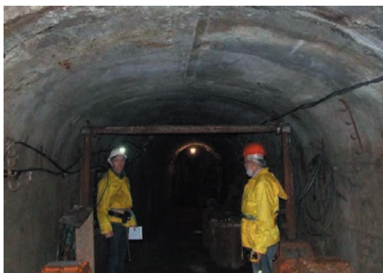
Ryc. 7. Przykłady prowadzenie inwentaryzacji i oceny makroskopowej elementów obudowy wyrobiska (Główna Kluczowa Sztolnia Dziedziczna w Zabrze i Kopalnia Ćwiczebna „SztYGarka” w Dąbrowie Górniczej)
