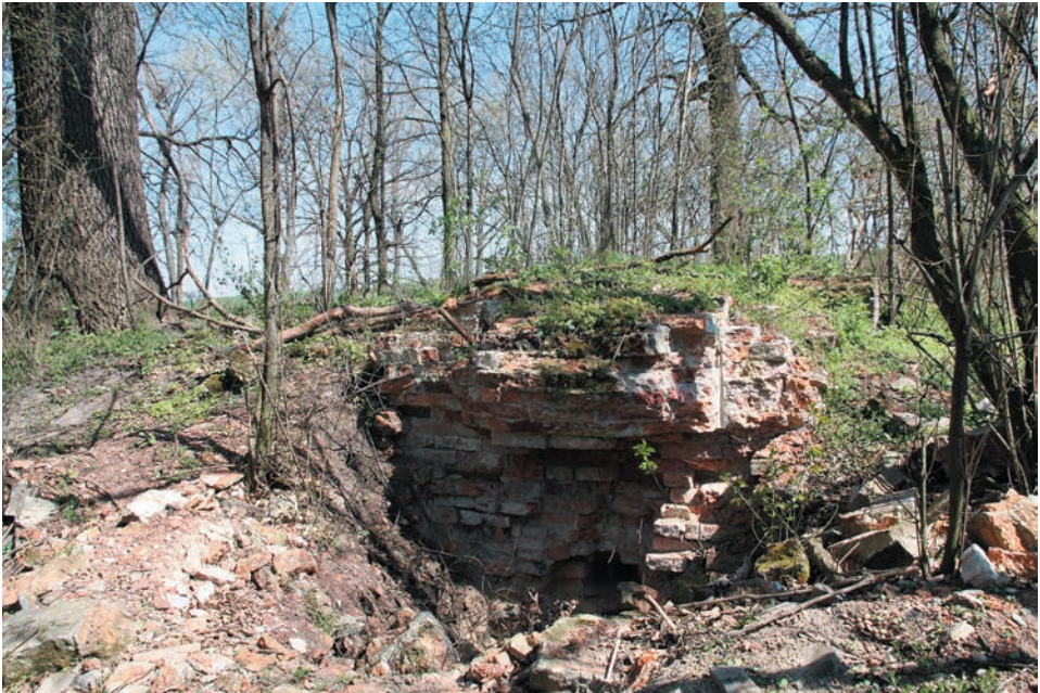
Ryc. 7. Ceglane fundamenty budowli usytuowane na południe od hałdy (fot. K. Maciejak)
