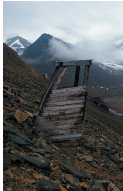
Ryc. 5. Drewniana konstrukcja zabudowana na wlocie sztolni G2b- \beta
