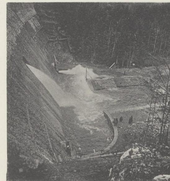
Abb. 8. Linker Grundablaß ohne Ansatzstück,
