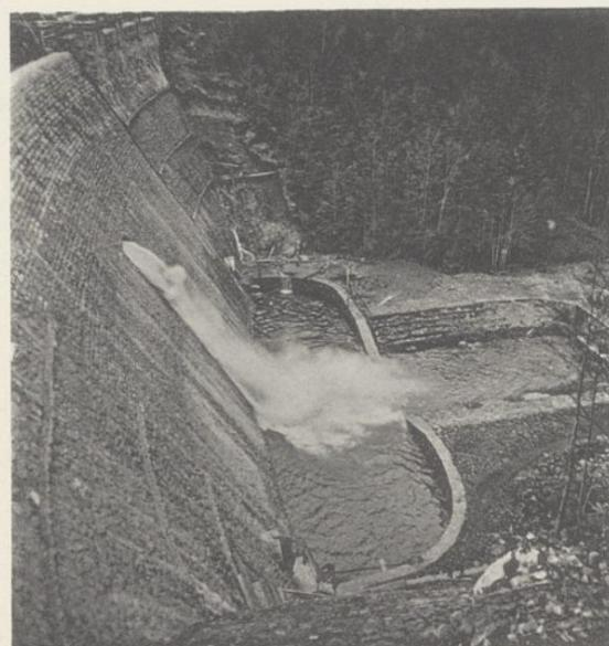
Abb. 2. Unmittelbar nach Lösung der Verschußtafel.
