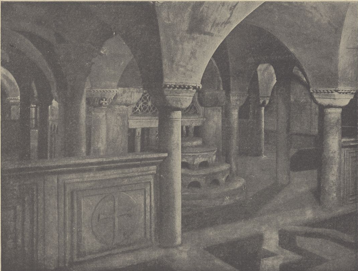
Abb. 6. Mittlerer Aufbau in der Krypta der Markuskirche in Venedig.
