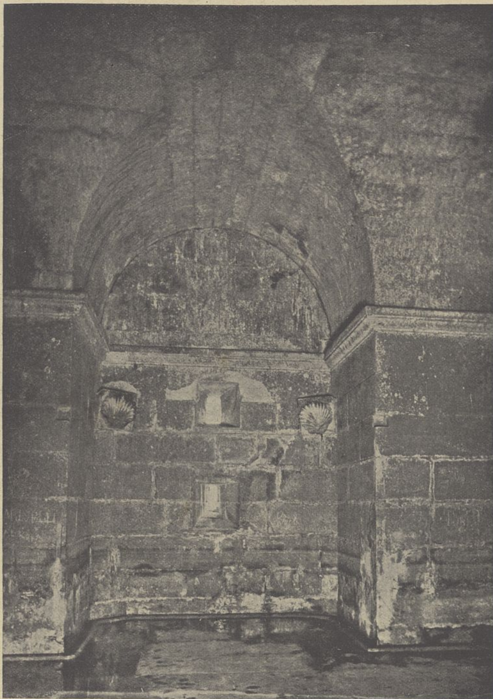
Abb. 12. Östliche Nische im Untergeschoß des Grabmals.
