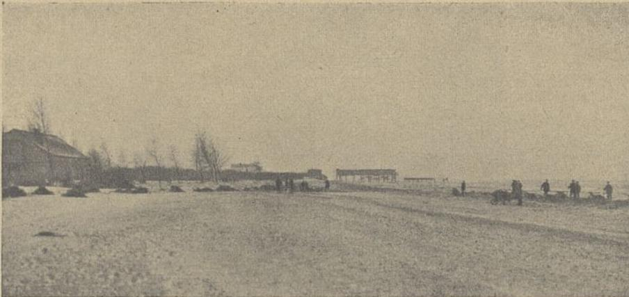
Abb. 17. Durch die Sturmflut von 1913/14 vollständig weggeschwemmte Vordüne bei Berg-Dievenow.
