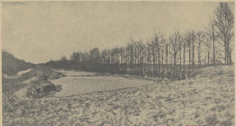
Abb. 15. Durchbruch des Damerower Seedeiches infolge der Sturmflut von 1913/14.
