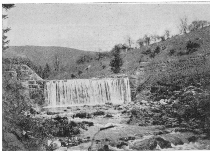
Ryc. 2. Zapora V (km 4.583).
