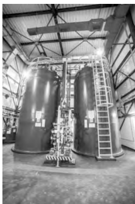
Rys. 1. Przykłady wdrożenia trzech metod modernizacji instalacji odsiarczania spalin: a) nowy poziom zraszania, b) instalacja dozowania kwasu organicznego, c) półka sitowa w absorberze.
