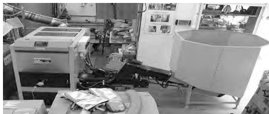
Rys. 1. Kocioł typu Bio-warmer firmy CWD Cichewicz o mocy 50 kW z zasobnikiem na biomasę i podajnikami ślimakowymi, z żeliwnym rusztem schodkowym, ruchomym
