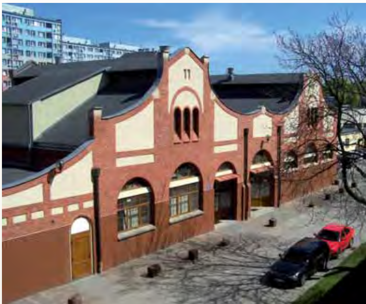
Budynek dawnej kotłowni, dziś Archiwum uczelni i laboratorium chemiczne
