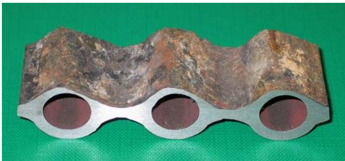
Rys. 10.2. Przykład degradacji powierzchni w kotle energetycznym
